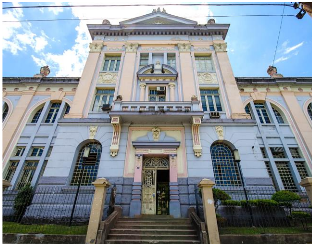
Figura 2. Instituto Parobé – sede do Departamento de Engenharia Mecânica
