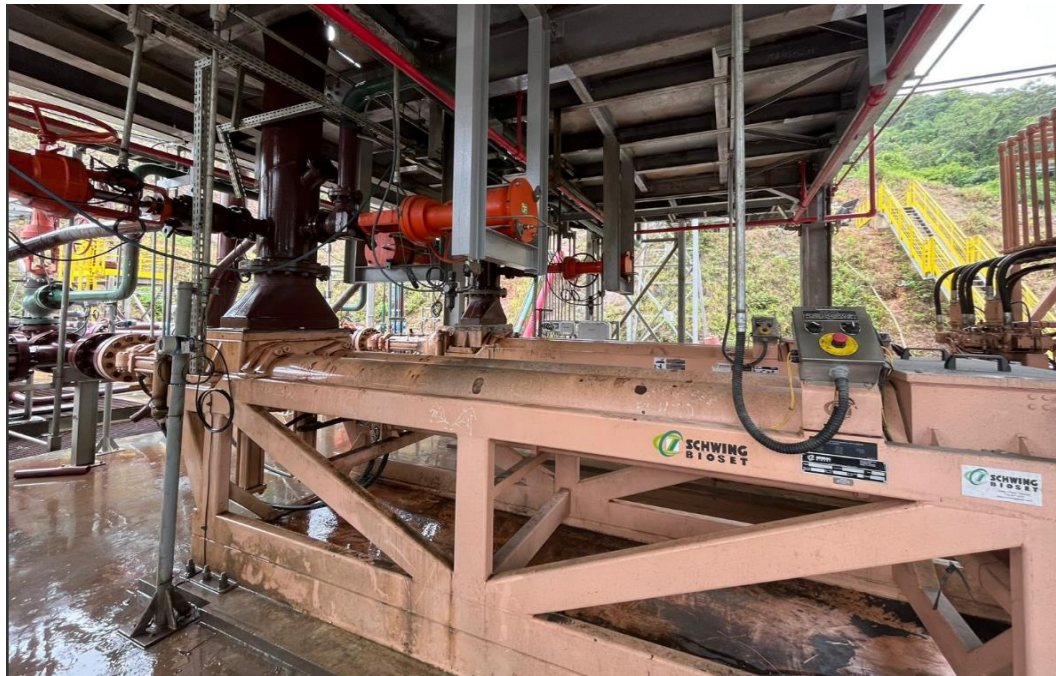
Figura 15 - Bomba de deslocamento positivo (pistão).
