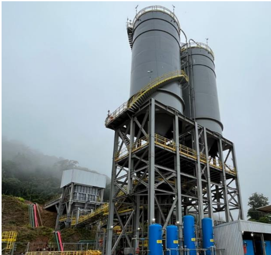
Figura 11 - Silos de armazenamento de cimento.
