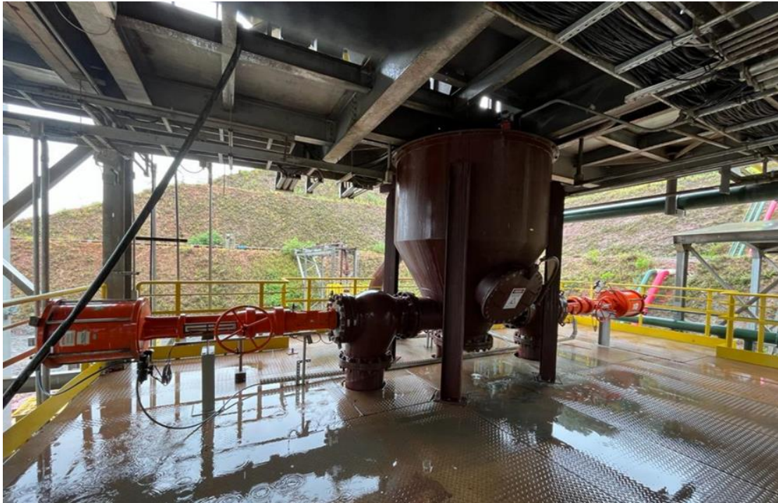
Figura 16 - Reservatório de pasta prévio ao bombeamento.
