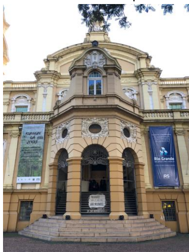
Figura 53 - Comunicação Externa Fachada Principal
