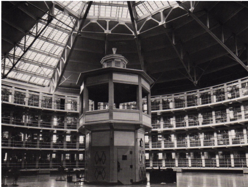
Figura 2 — Interior de Stateville Correctional Center (Illinois, EUA)
