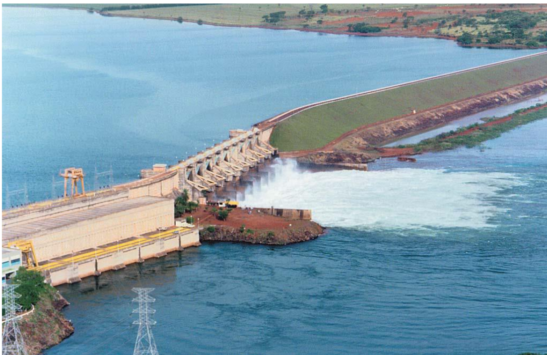
Figura 3.1 – Vista aérea da barragem da UHE Porto Colômbia.
