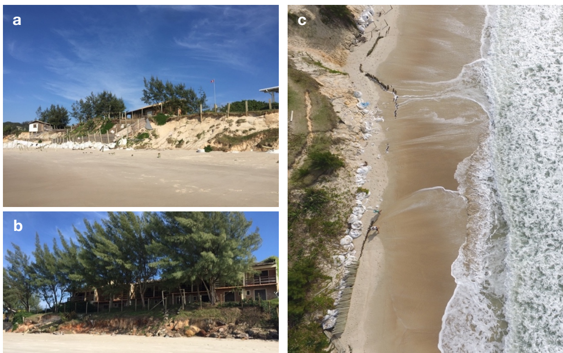
Figura 3. Indicadores visuais de erosão na Praia da Barra, Garopaba, SC. a. Observam-se casas construídas próximas à linha de costa (LC) da PB. Atualmente, as casas coincidem com a LC em diversos pontos, quando abordada sob o indicador escarpa e/ou base da duna. Além disso, é possível visualizar sacos de areia, mourões e cercas de madeira a fim de conter a ação das ondas sobre a LC. Atenta-se a uma casa de madeira no canto esquerdo, a qual está amarrada com cordas para evitar seu tombamento. b. Diversas raízes de plantas e solo expostos. c. Perspectiva aérea dos indicadores de erosão citados anteriormente (imagem obtida com veículo-aéreo-não-tripulado). Fonte: autoral.
