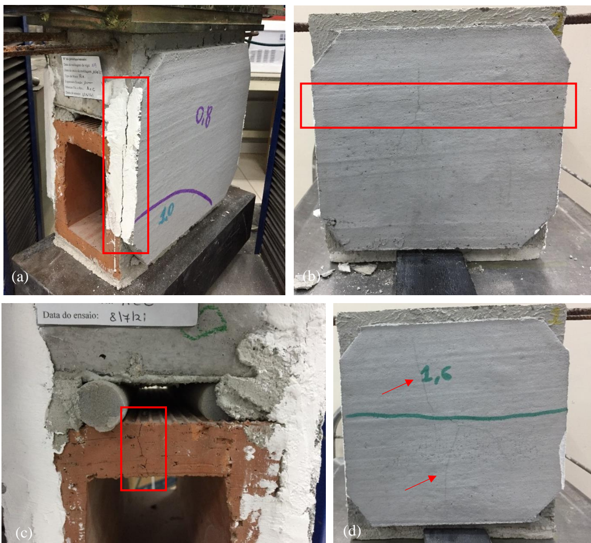
Figura 57 – Principais danos ao longo do ensaio para a configuração Fix. 1 e 2 cm FI-RB: (a) descolamento do revestimento, (b) fissura horizontal no revestimento, (c) ruptura do bloco cerâmico e (d) fissuras por retração
