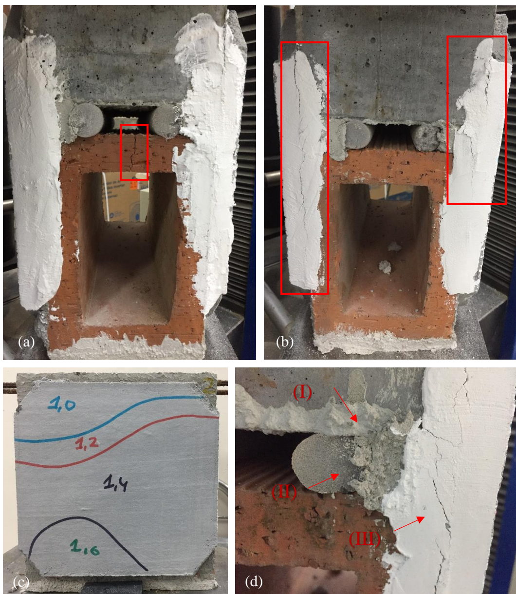
Figura 61 – Principais danos ao longo do ensaio para a configuração Fix. 1 e 2 cm FB-RB: (a) ruptura do bloco, (b) e (c) descolamento do revestimento e (d) esmagamento da fixação superior
