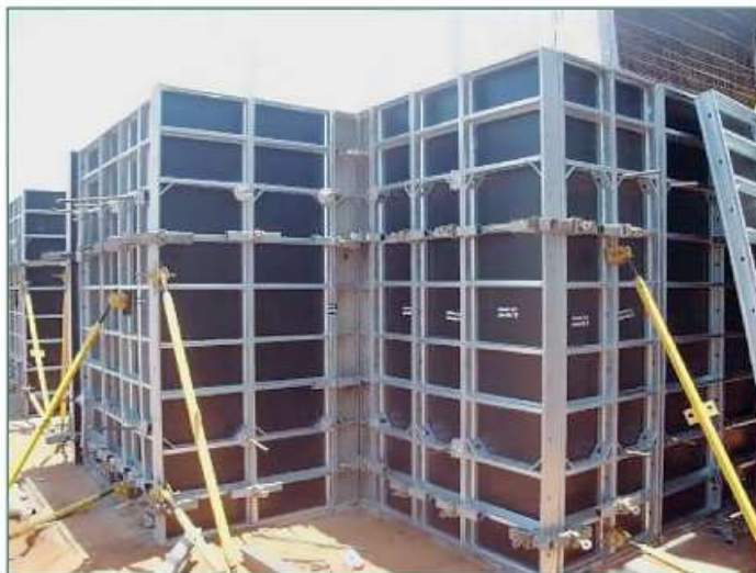
Figura 15 – Fôrmas de Madeira
