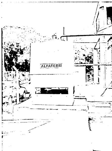
Figura 27 - Nova torre de refrigeração do CPD, 2004
