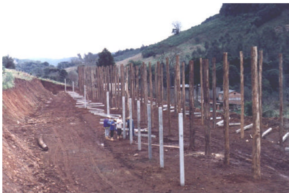
Construção de Aviário
