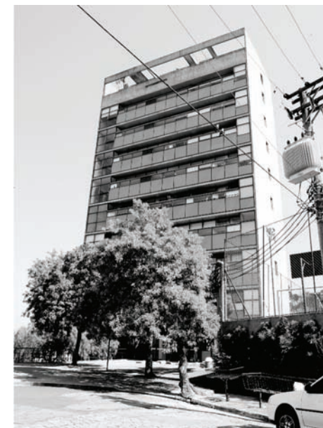
Figura 108: Vista externa do acesso Edifício Jaraguá.
