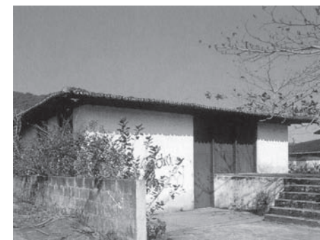
Figura 172: casa Lagoinha vista externa-Fonte: Spiro, Annette. Paulo Mendes da Rocha : works and projects. Zürich: Verlag Niggli AG. Sulgen, 2002. 271 p. : il. p52
