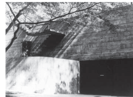
Figura 157: Vista acesso e escada para cobertura casa Millan
