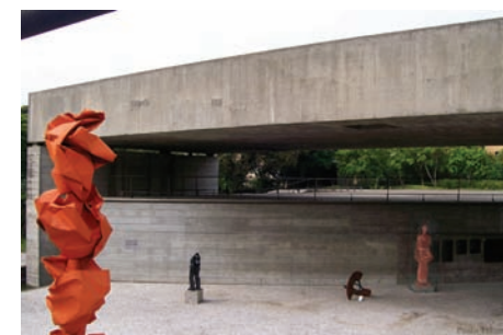
Figura 209: Vista viga e esplanada MuBE. Fonte: Foto Ana Souto.
