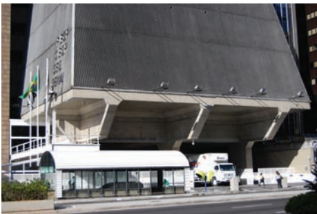
Figura 305/306:Imagens do acesso o alargamento da Avenida Paulista.
