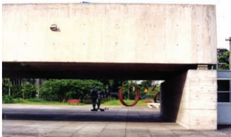
Figura 213: Vista viga e esplanada MuBE. Fonte: foto Ana Souto.
