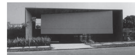
Figura 198: Vista fachada frontal Casa Antônio Junqueira. Fonte: SPIRO, Annette, 2002, p.86.
