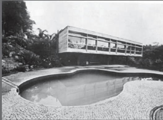
Residência James Francis King, 1972, SP
