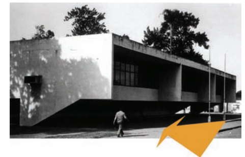
Figura 85: Vista fachada da rua Fonte: ARTIGAS, Rosa. Paulo Mendes da Rocha . projetos 1957-1999, 3ªed. rev., Cosac Naify, 2006, 240p.,p.139.
