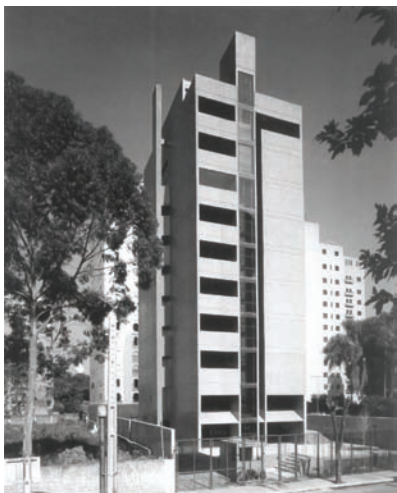
Figura 111: Vista fachada frontal Aspen. Fonte: ARTIGAS, Rosa. Paulo Mendes da Rocha . projetos 1957-1999, 3ª ed. rev., Cosac Naify, 2006, 240p., p.159.
