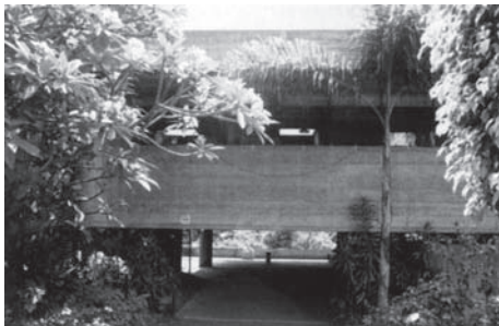
Figura 127:Vista da Rua casa Masetti
