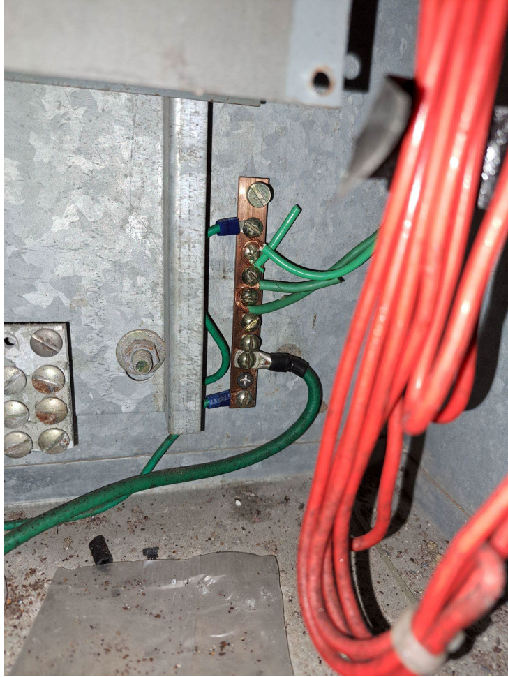
Ilustração 29 – Quadro de disjuntores do pavimento superior
