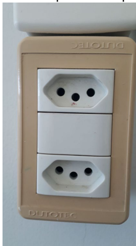
Ilustração 16 – Tomada dupla de três pinos de padrão atual
