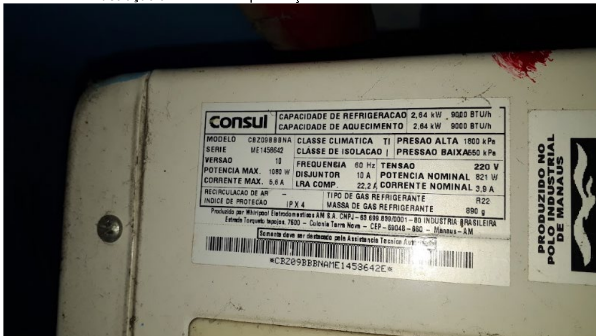
Ilustração 9 – Placa de especificações técnicas do condicionador de ar
