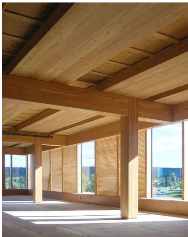
Figura 9 - Edificação construída em MLCC
