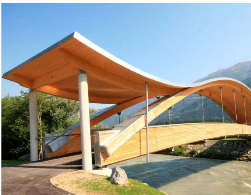
Figura 7 - Ponte construída em MLC
