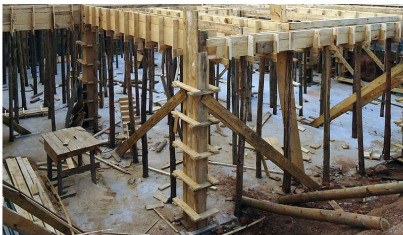
Figura 3 - Madeira roliça para escoramento
