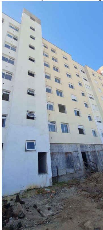
Figura 31 – Fachada do empreendimento com janelas alocadas
