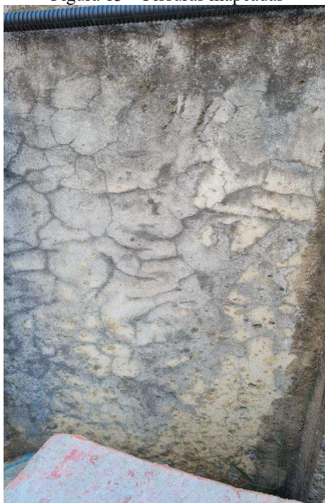
Figura 13 – Fissuras mapeadas
