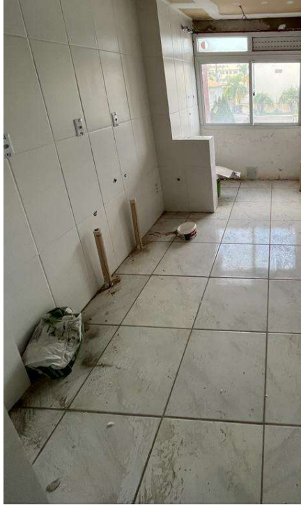
Figura 18 – Revestimento cerâmico na cozinha
