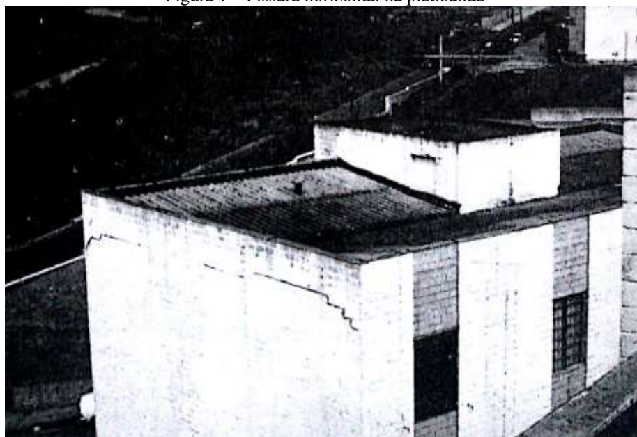
Figura 1 – Fissura horizontal na platibanda
