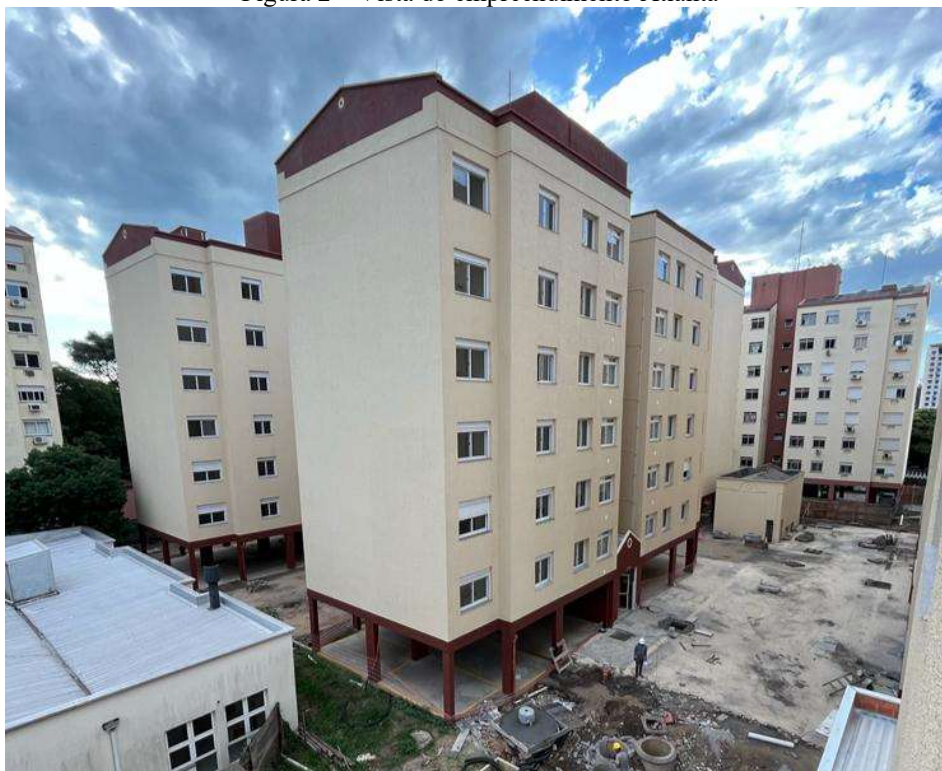
Figura 2 – Vista do empreendimento Atlanta
