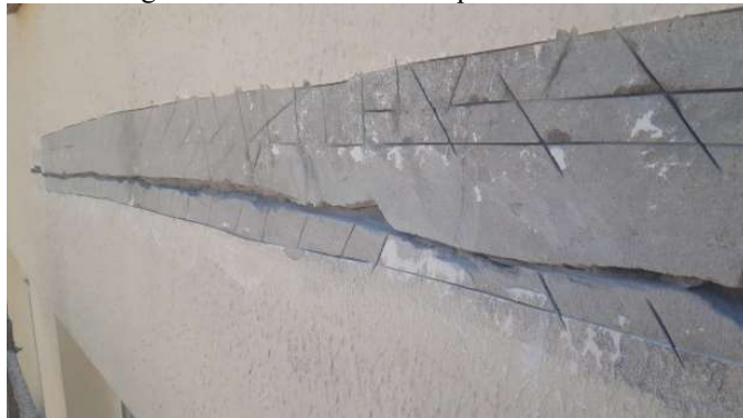
Figura 11 – Corte da fissura para tratamento
