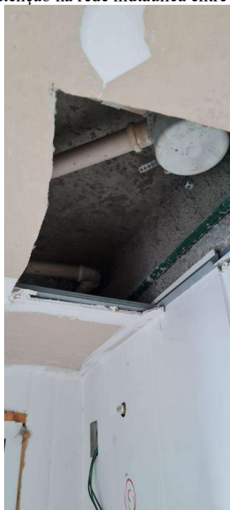
Figura 30 – Manutenção na rede hidtáulica entre o forro acartonado
