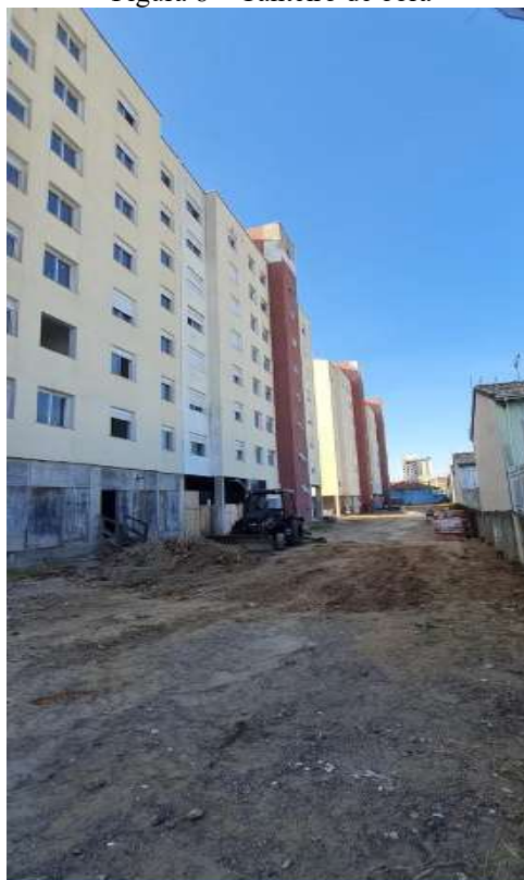
Figura 8 – Canteiro de obra
