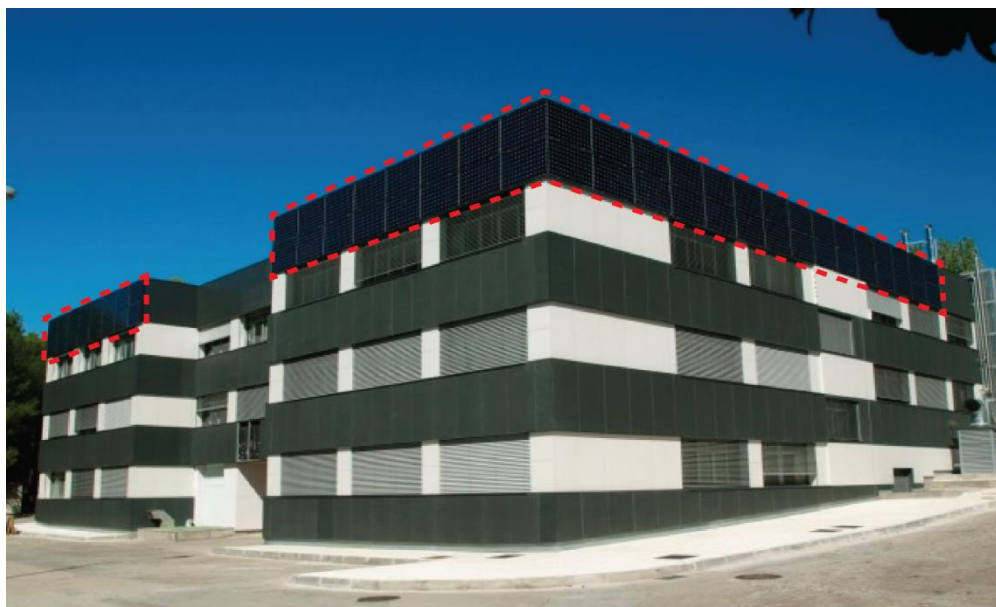
Figura 6: Renovação de fachada utilizando o sistema de fixação de fachadas ventiladas com utilização de placas cerâmicas e placas fotovoltaicas (destaque em vermelho). Fonte: adaptado de Martín-Chivelet et. al. (2018)
