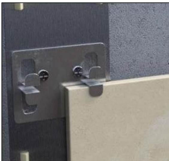
Figura 7: Sistema de fixação visível. Fonte: Eliane Tec (2023)
