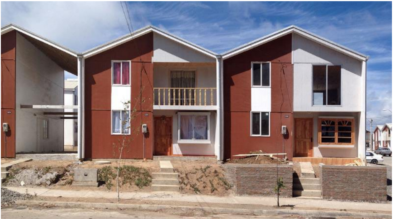
Fig. 151 e 152 – Elemental, Villa Verde, Chile. Foto de fachadas com a construção apenas finalizada e após a ampliação parcial ano depois.
