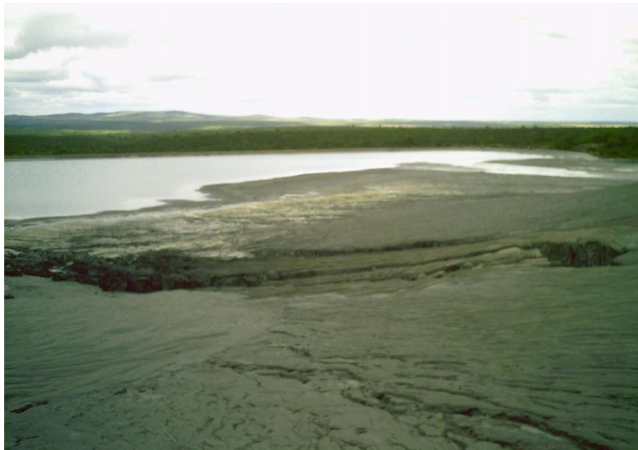
Figura 3.3 Reservatório de resíduos do processamento de ouro.
