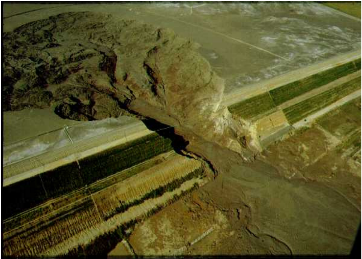
Figura 2.31: Ruptura por liquefação na represa de resíduos de ouro (Merriespruit, Sul Africa, fevereiro 1994)
