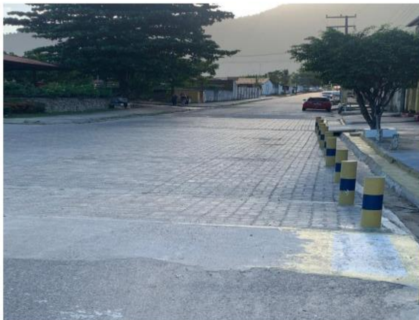
Figura 7: Obra de drenagem concluída na Rua Raimundo Pereira Campos. Fonte: Autor, 2022
