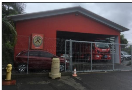
Figura 1 – Unidade 2 do Corpo de Bombeiros Voluntários de Joinville
