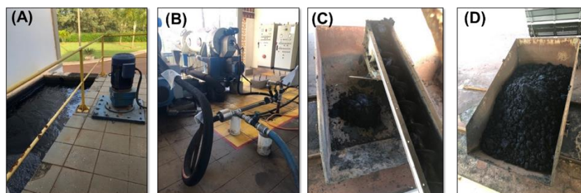
(A) Lodo bruto; (B) Processo de desidratamento (centrifugação); (C e D) Lodo desidratado
