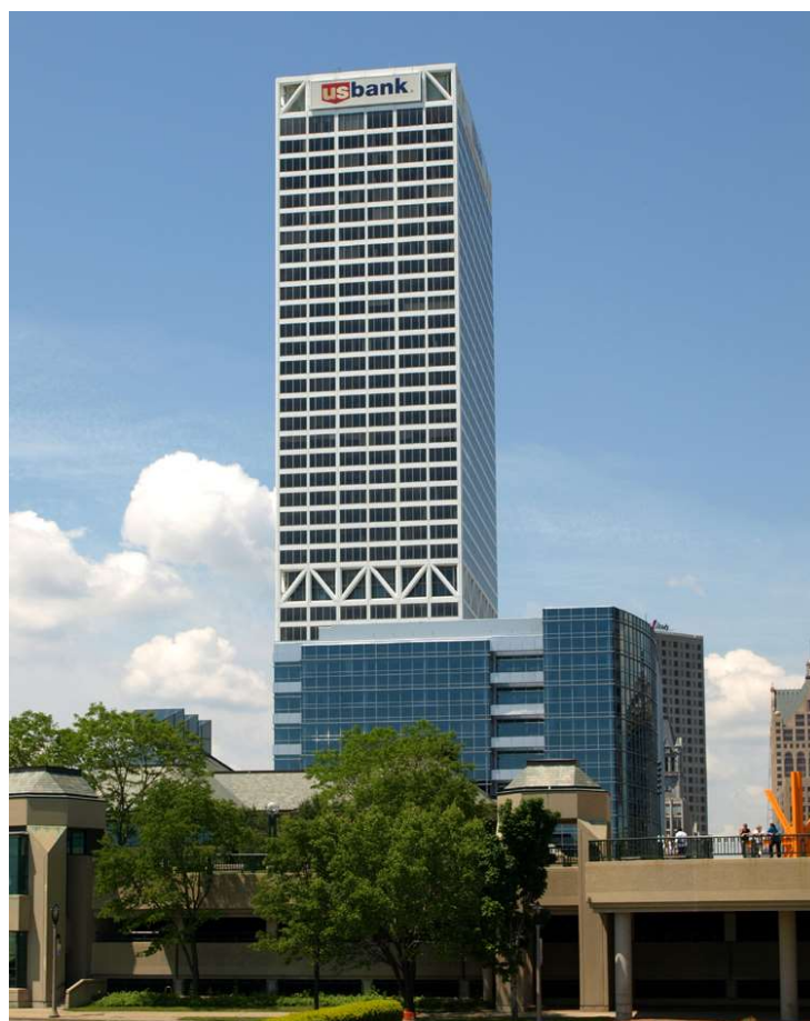
Figura 14 – Fachada do edifício First Wisconsin Center, em Milwaukee/EUA com o sistema belt-truss
