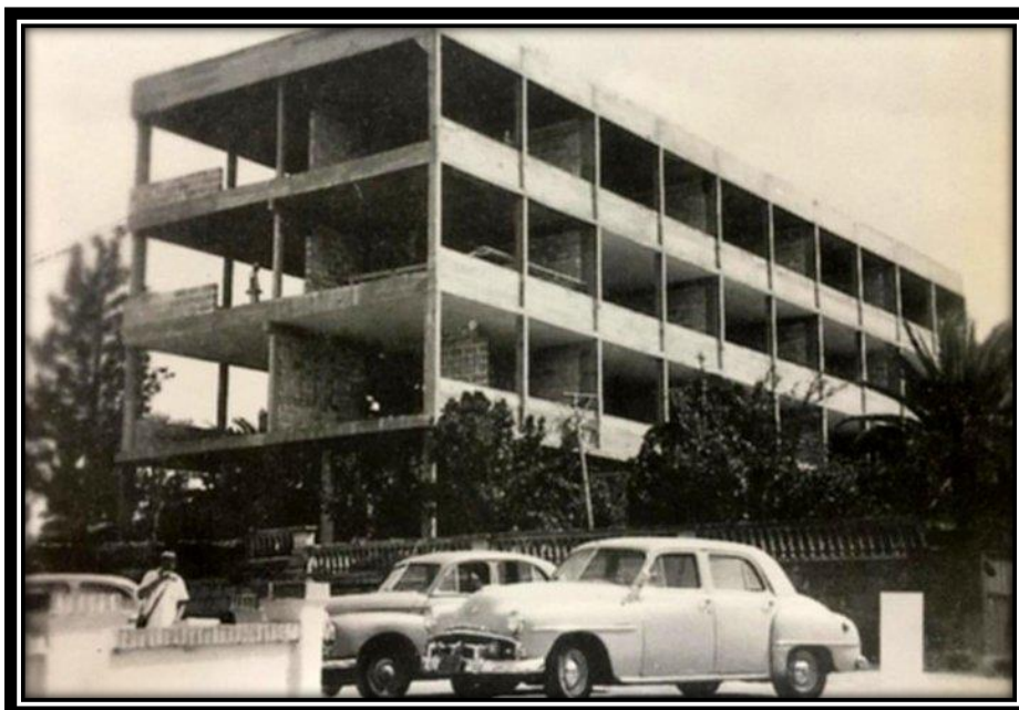
Imagem 9 – Prédio atual da escola em construção no ano de 1954.
