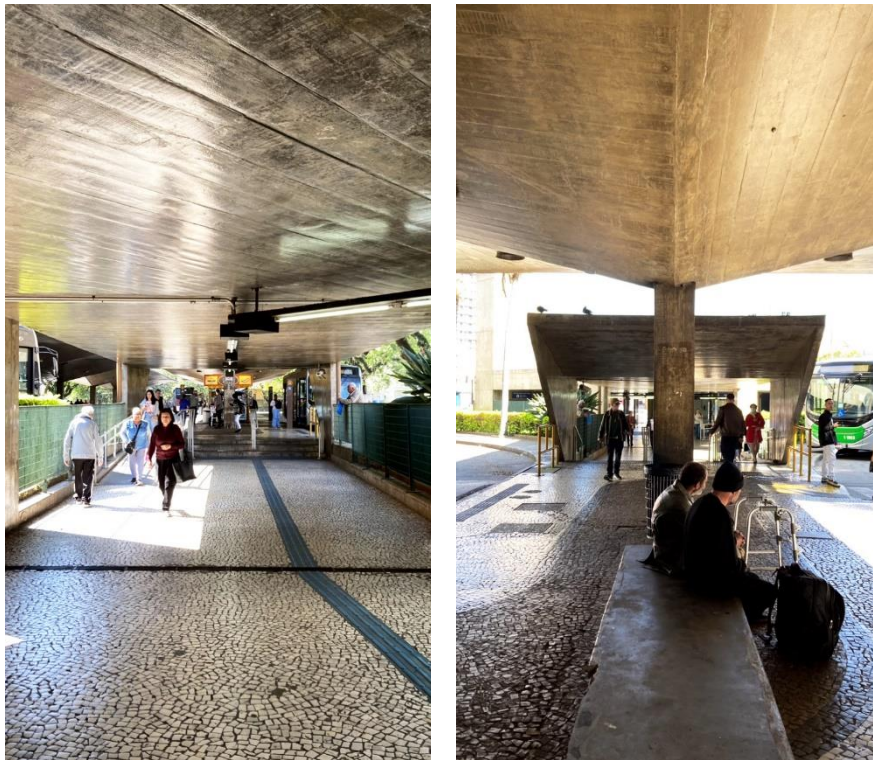
Figura 99 - Estação Vila Mariana - Acesso B - marquise para o terminal rodoviário.
