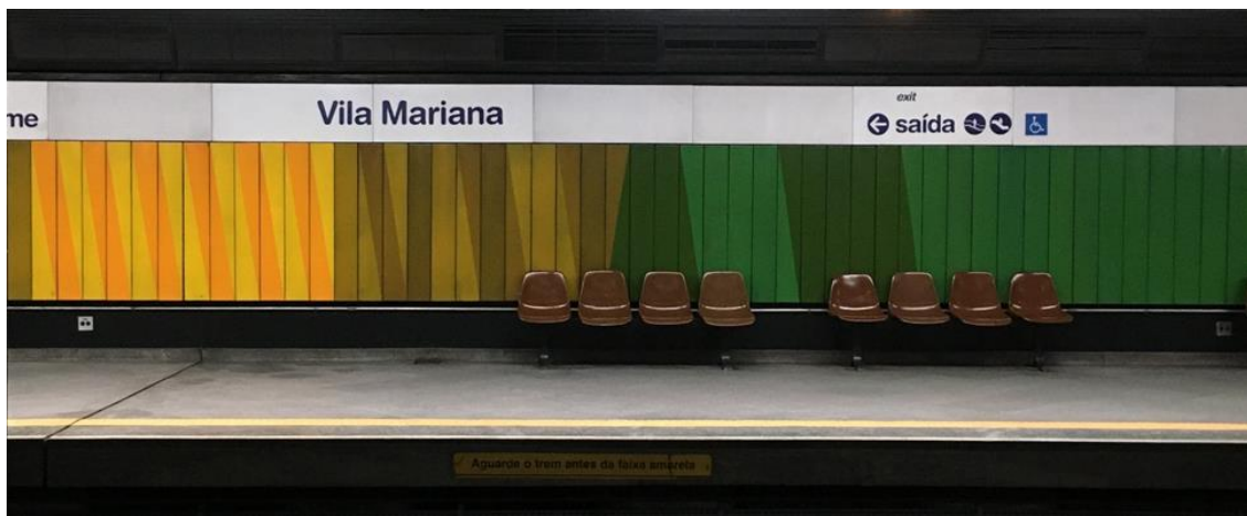
Figura 76 - Estação Vila Mariana – painel tipo 2 na plataforma
