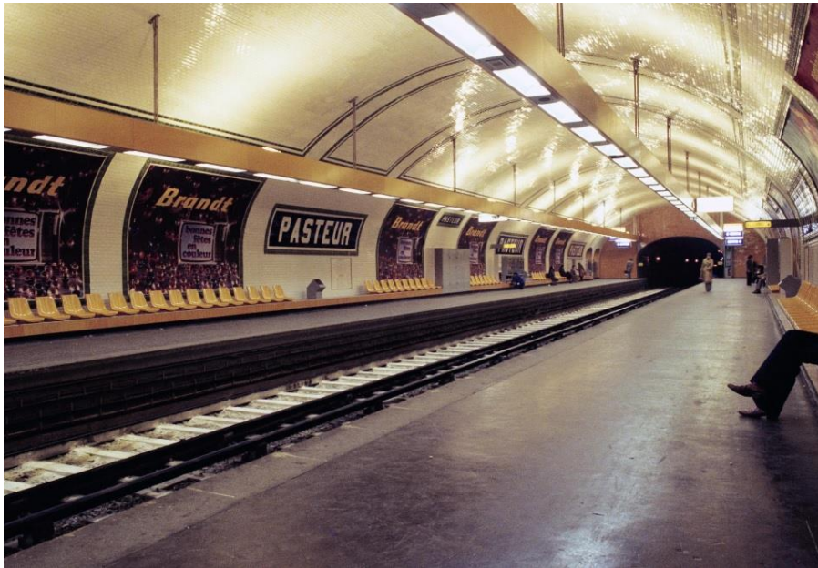
Figura 20 - Estação Pasteur, modelo de estação escavada em túnel e com revestimento em cerâmica esmaltada branca.
