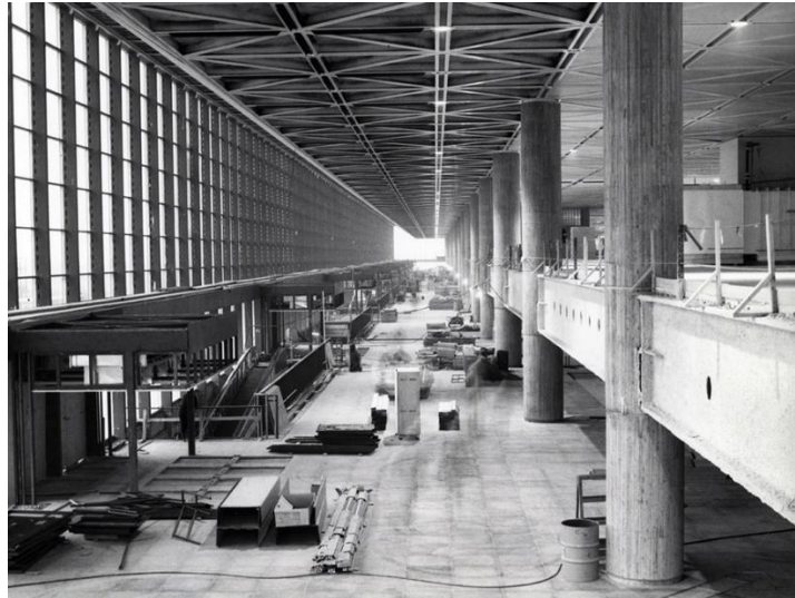
Figura 39 - Aeroporto de Mirabel em construção
