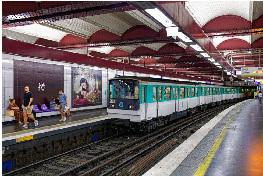
Figura 18 - Estação Opéra da Linha 3 do Metrô de Paris, exemplo de estação com escavação em vala e cobertura metálica e abóbadas de tijolo.
