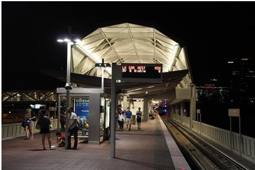
Figura 56 - Estação Tysons Corner, modelo mais recente implantado na Linha Cinza em 2022.
