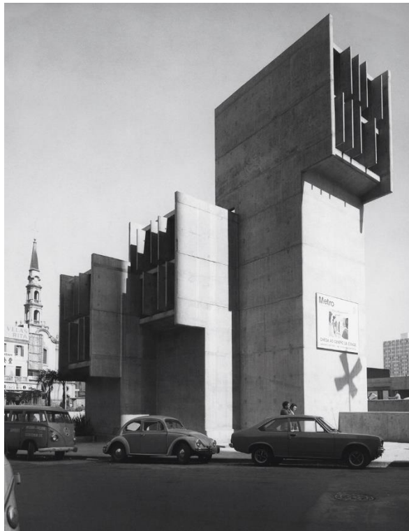
Figura 86 – Estação Liberdade – Torres de ventilação
