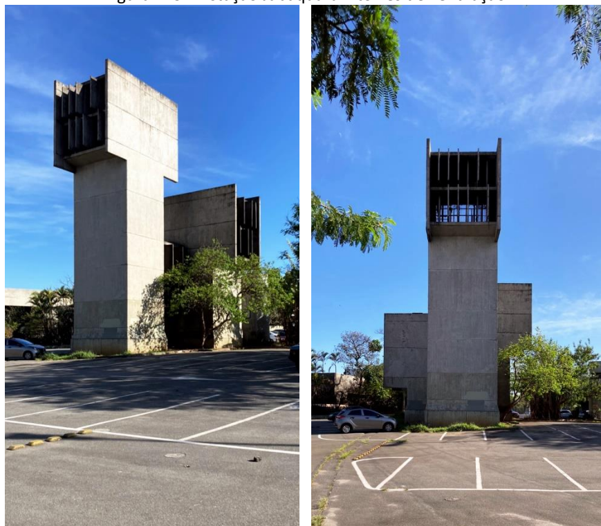
Figura 129 – Estação Jabaquara – torres de ventilação
