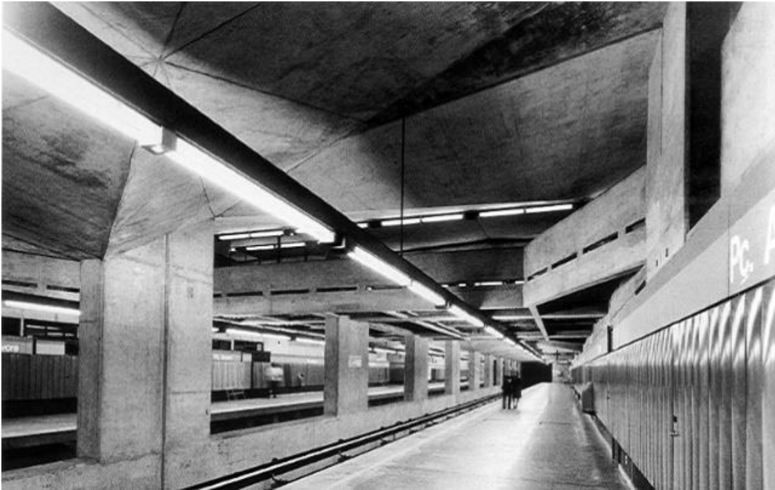
Figura 1 - Estação Praça da Árvore
