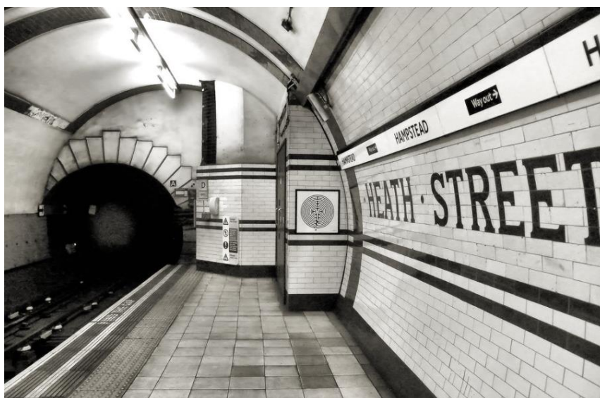
Figura 13 - Extremidade da plataforma da Estação Hampstead, apresentando as secções típicas dos túneis cilíndricos de via e da estação
