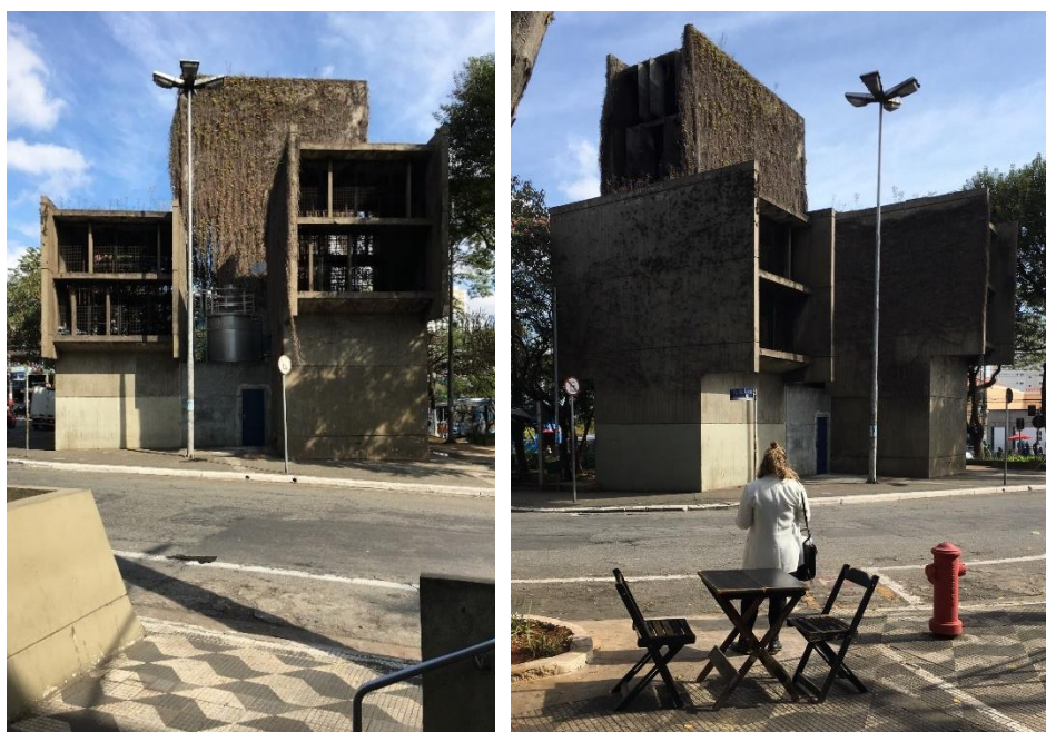
Figura 119 - Estação Praça da Árvore - Torres de ventilação
