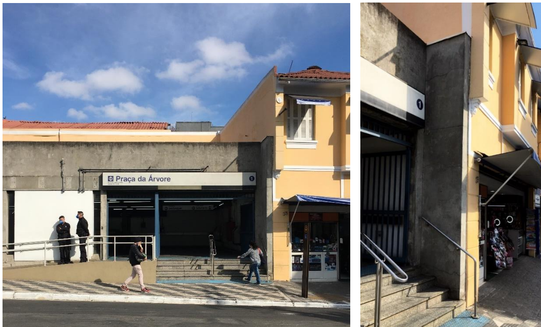
Figura 118 – Estação Praça da Árvore – Acesso oeste.
