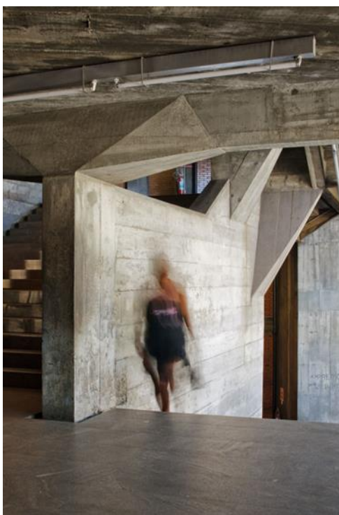
Figura 8 - Edifício Jerônimo Ometto, Rio de Janeiro
