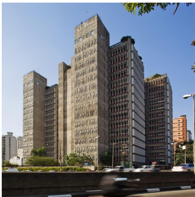
Figura 5 - Condomínio São Luiz, sede da Promon Engenharia em São Paulo
