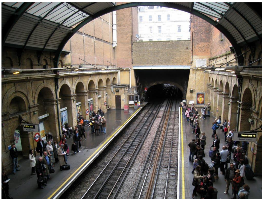
Figura 12 - Plataforma da Estação Gloucester Road, com setor aberto para ventilação natural.
