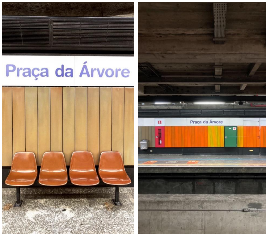
Figura 125 - Estação Praça da Árvore - Painéis de plataforma.
