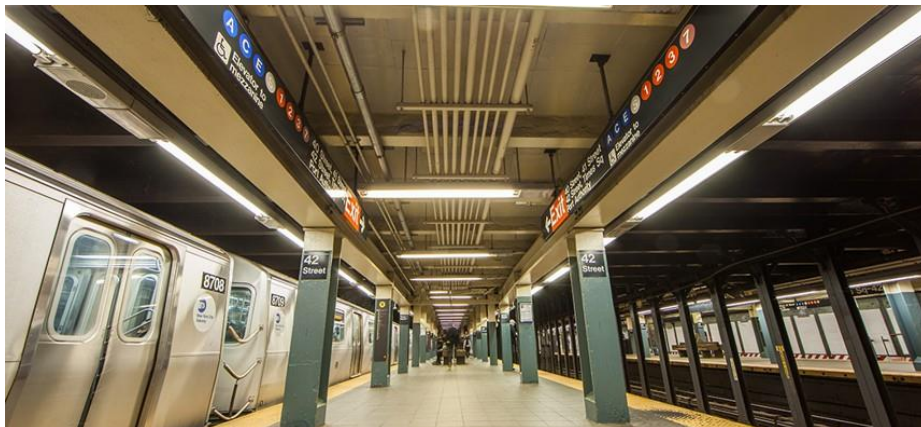
Figura 24 - Estação típica do Metrô de Nova Iorque, com escavação a céu aberto e estrutura metálica.
