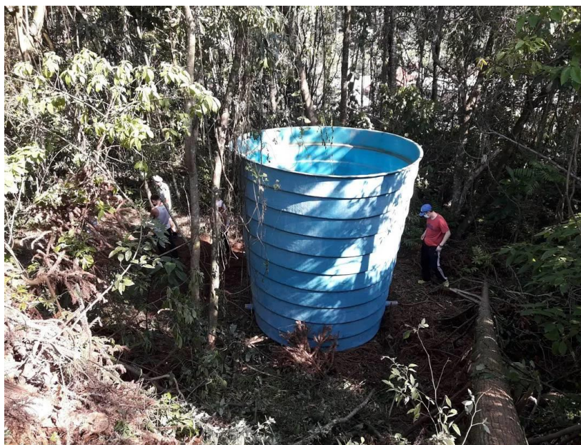
Figura 11 - Reservatório de água da Horta Comunitária da Associação Tchon Ji
