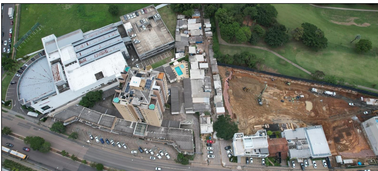
Figura 6: Imagem obtida por drone das obras em desenvolvimento na fronteira com o território do Quilombo Kédi. Fonte: Giuliano Lucas, 2022.
