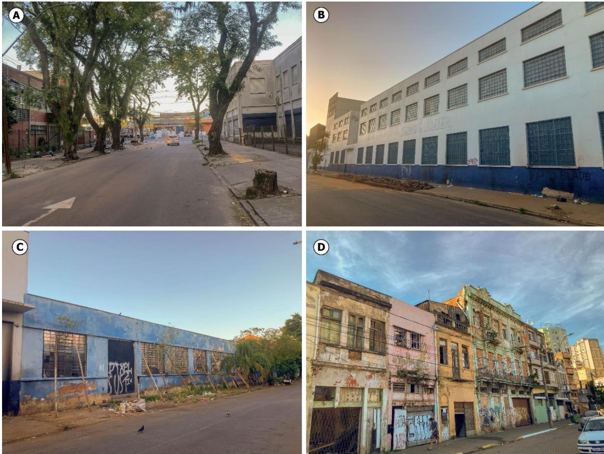
Figura 36. A – Rua Paraíba e loteamento Santa Terezinha (fundo), B – Fábrica na Rua Hoffmann, C – Fachada de imóvel em estruturação escorada e D - Imóveis inventariados na Rua Voluntários da Pátria nas proximidades do nº 811. Imagens de 14/01/2024. Elaborado pelo autor.
