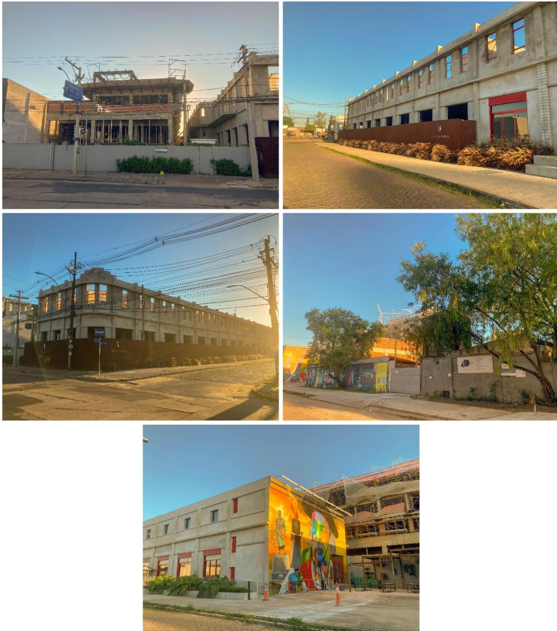
Figura 40. Empreendimento 4D Complex House. Imagens de 14/01/2024. Elaborado pelo autor.
