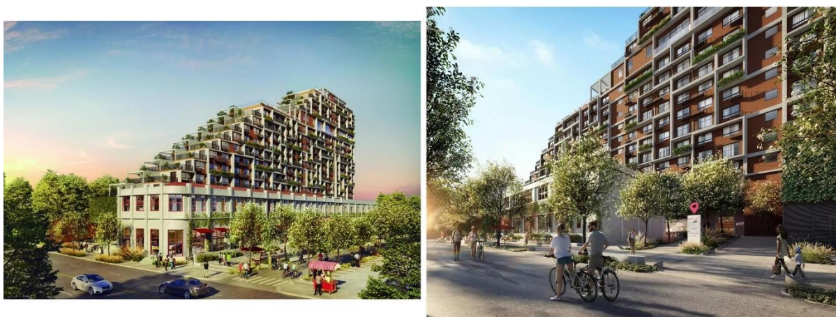
Figura 29. Empreendimento 4D Complex House + Mercado Gastronômico. Fonte:
