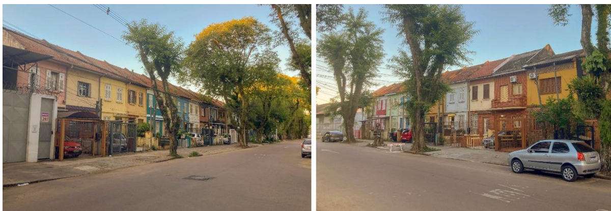
Figura 39. Bens em estruturação na Rua Paraíba. Imagens de 14/01/2024. Elaborado pelo autor.
