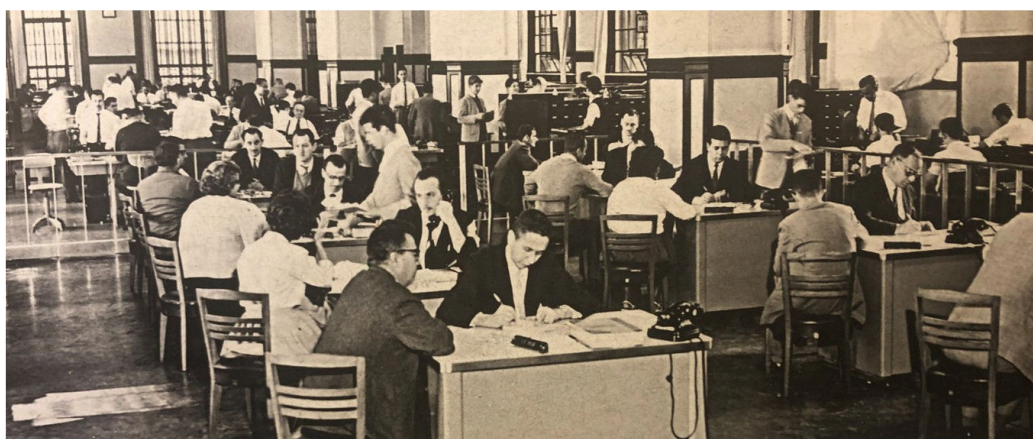
Figura 43: Interior do Edifício Alexandre Mackenzie
