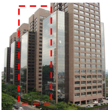
Figura 107: Centro Empresarial Água Branca, com marcação da torre que abriga a Viacom
