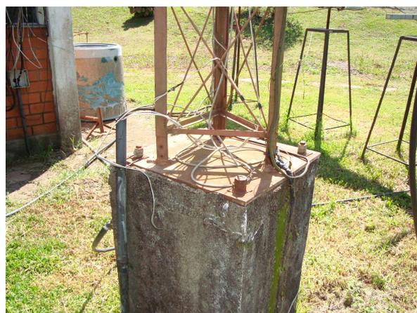
**Figura 39 – Fixação da base da estrutura da torre**
