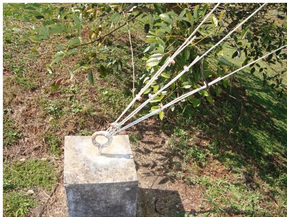
**Figura 38 – Chumbadores responsáveis pela fixação dos cabos**
