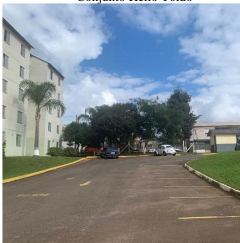
Figura 4.60: Pavimentação na área 5 no Conjunto Hélio Toldo
