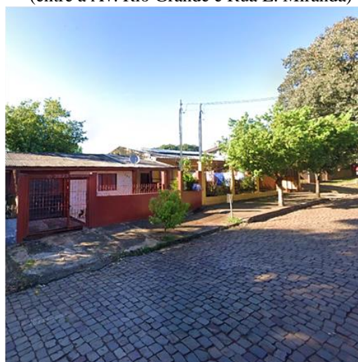
Figura 4.113: Residências na Rua Dona Paula (entre a Av. Rio Grande e Rua L. Miranda)
