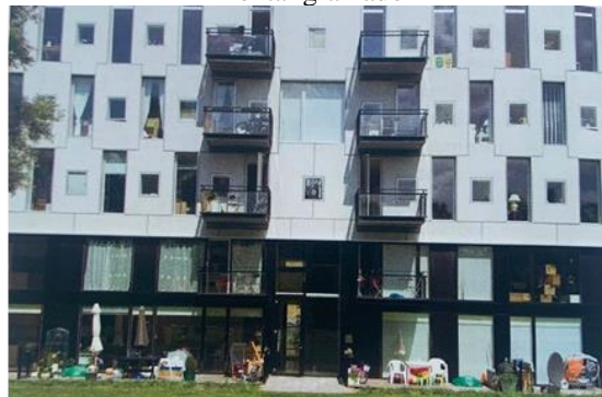
Figura 2.33: Edificações residenciais com recuo frontal gramado
