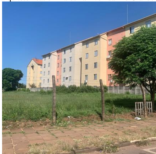
Figura 4.92: Edificações com características arquitetônicas similares na Avenida Rio Grande
