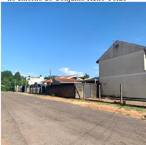
Figura 4.84: Edificações muradas na Rua Chuí no entorno do Conjunto Hélio Toldo
