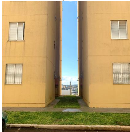
Figura 4.44: Vista acesso a área 11 no Conjunto Boqueirão II
