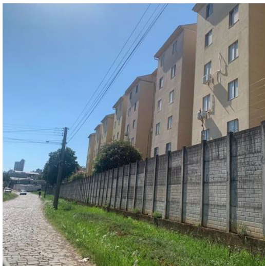
Figura 4.100: Muro na Rua Onofre Pedroso
