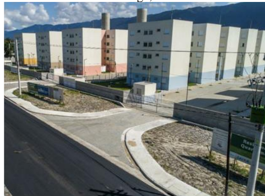
Figura 2.19: Muros no Conjunto Jardim Raphael – Bertioga, SP
