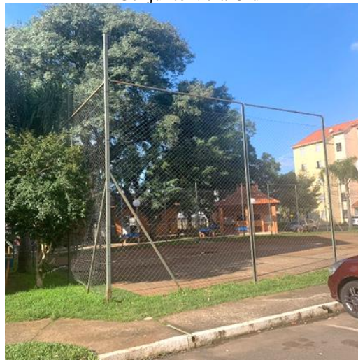
Figura 4.18: Vista quadra de esportes (área 8) no Conjunto Vera Cruz
