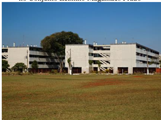
Figura 2.16: Uso de pilotis no pavimento térreo no Conjunto Zezinho Magalhães Prado
