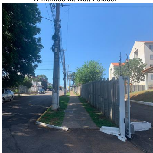
Figura 4.104: Acesso Conjunto PAR Boqueirão II murado na Rua Pulador
