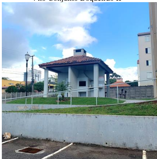
Figura 4.35: Acesso quiosque (área 3) para a área 4 no Conjunto Boqueirão II
