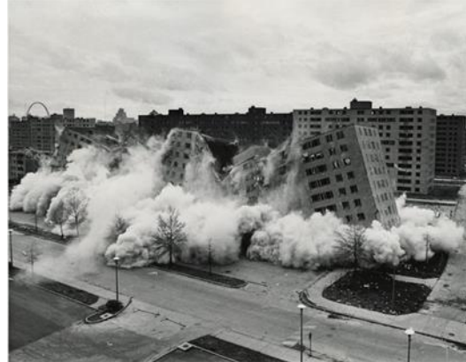
Figura 2.7: Demolição do Conjunto Habitacional Pruitt-Igoe
