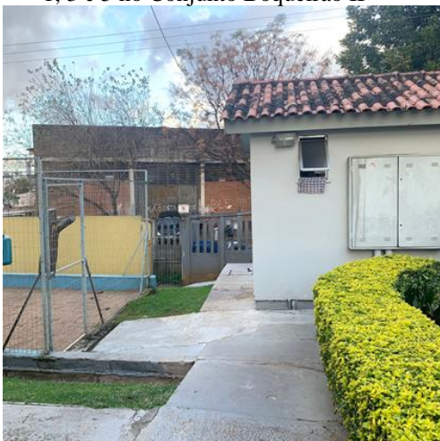
Figura 4.11: Vista a partir da área 2 para as áreas 1, 3 e 5 no Conjunto Boqueirão II
