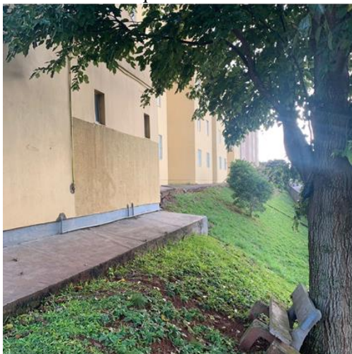
Figura 4.13: Vista área 12 no Conjunto Boqueirão II
