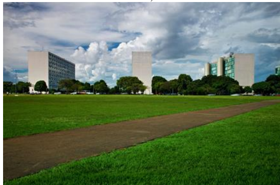
Figura 2.30: Edificações afastadas da calçada – Brasília, DF
