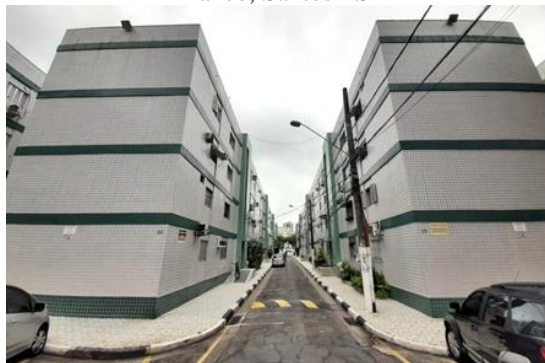
Figura 2.12: Vista blocos com paredes cegas – Conj. Marechal Humberto de Alencar Castelo Branco, Santos - SP
