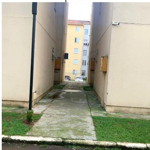
Figura 4.43: Vista acesso a área 9 no Conjunto Boqueirão II
