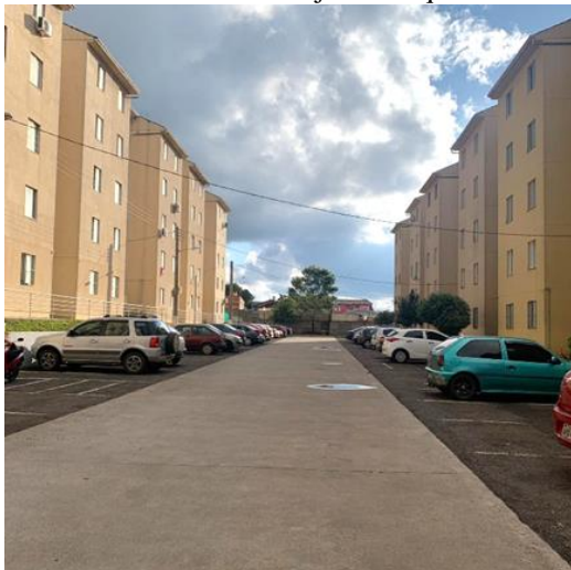
Figura 4.7: Circulação e estacionamentos em frente aos blocos no Conjunto Boqueirão II
