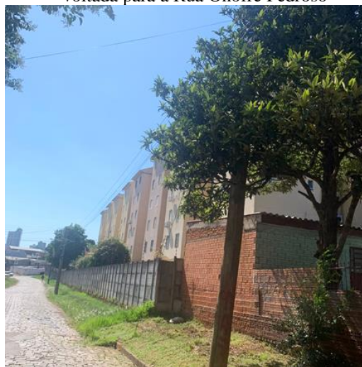
Figura 4.101: Edificação com parede cega voltada para a Rua Onofre Pedroso
