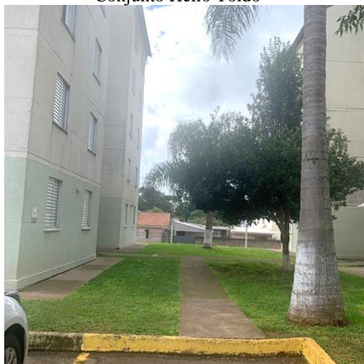
Figura 4.63: Vista área 21 a partir da área 18 no Conjunto Hélio Toldo
