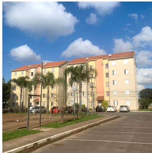
Figura 4.22: Vista circulação e estacionamentos em frente aos blocos (área 12) no Conjunto Vera Cruz
