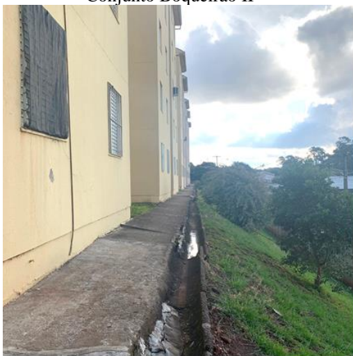
Figura 4.41: Talude existente na área 12 no Conjunto Boqueirão II
