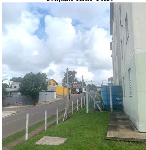
Figura 4.64: Caixas d'água cercadas na área 8 no Conjunto Hélio Toldo
