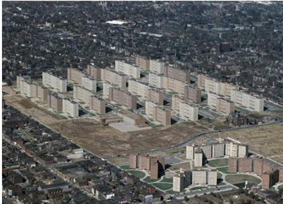
Figura 2.6: Implantação do Conjunto Habitacional Pruitt-Igoe
