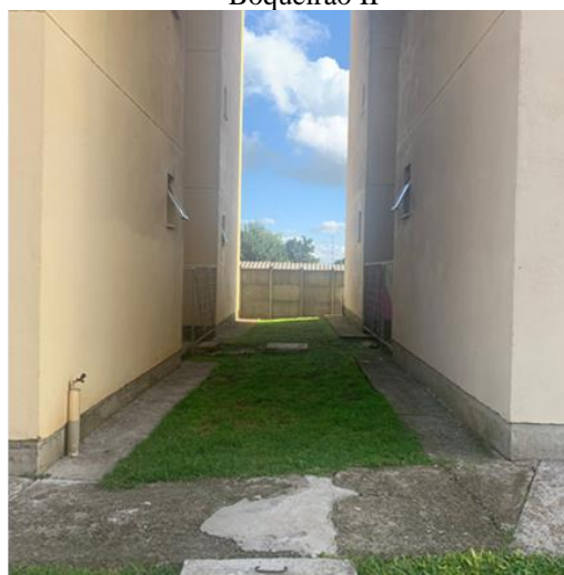
Figura 4.16: Vista área 11 no Conjunto Boqueirão II
