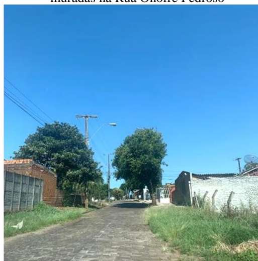
Figura 4.71: Vista edificações alinhadas e muradas na Rua Onofre Pedroso
