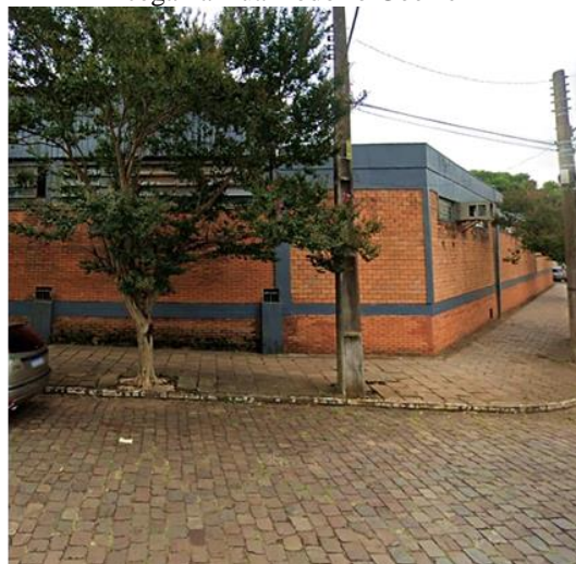
Figura 4.109: Edificação de serviço com parede cega na Rua Rodolfo Goelzer
