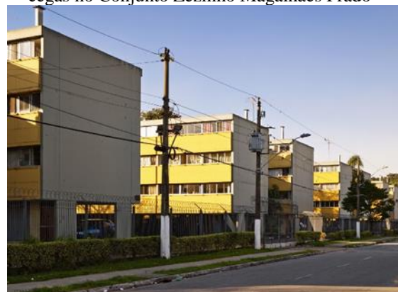
Figura 2.17: Fachadas laterais com empenas cegas no Conjunto Zezinho Magalhães Prado
