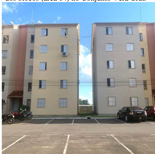
Figura 4.25: Vista espaço aberto entre as laterais dos blocos (área 14) no Conjunto Vera Cruz
