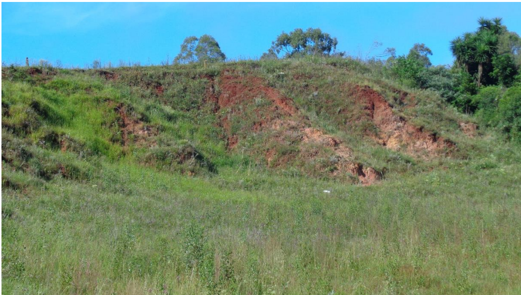
Figura 18: Afloramento típico da Formação Tupanciretã evidenciando a grande suscetibilidade aos processos erosivos devido seu caráter friável, pouco cimentado e intensamente alterado. Tupanciretã-RS. Do autor.
