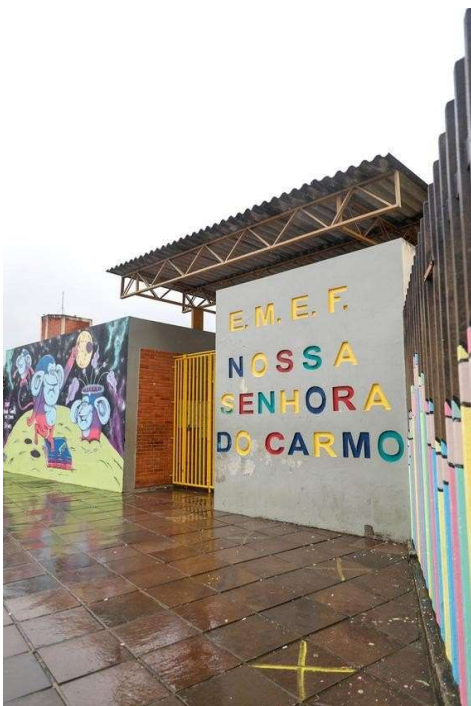
Imagem 01 – fachada da escola
