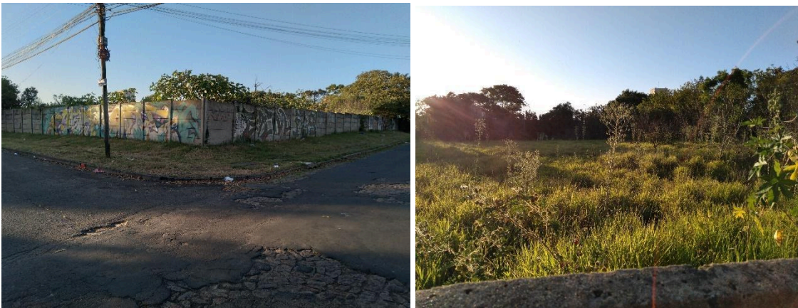
Rua Comandaí esquina com a Rua Raul Moreira
