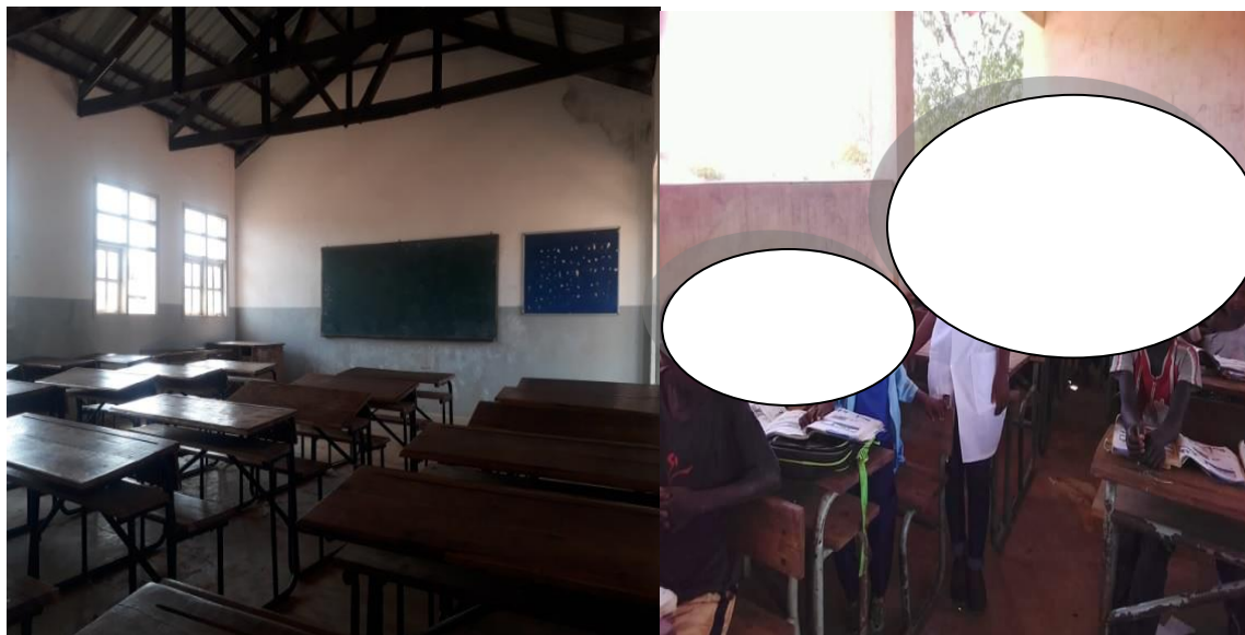
Figura 8: Ambiente das salas de aulas com carteiras em duas escolas primárias de construção convencional em Nampula
