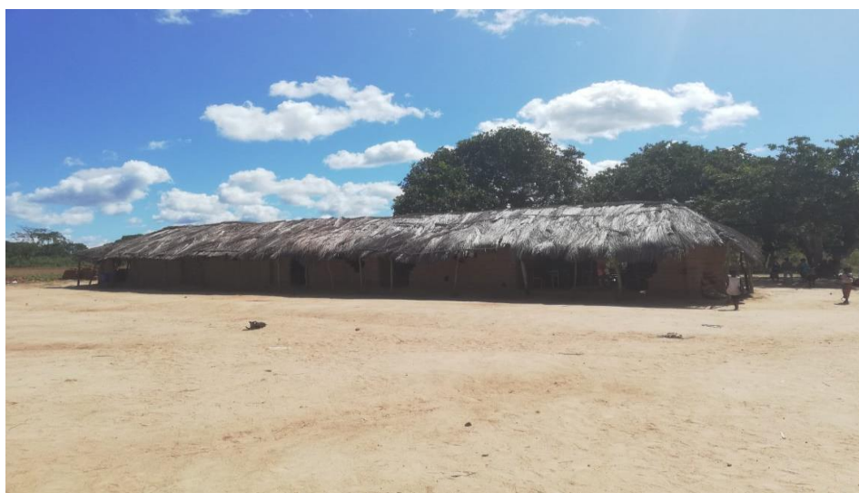
Figura 5: Edifício escolar construído com material precário em Nampula
