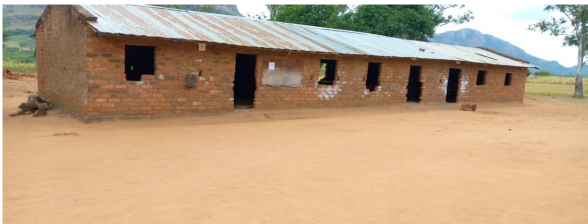
Figura 4: Edifício escolar construído com material semi-convencional em Nampula, Moçambique
