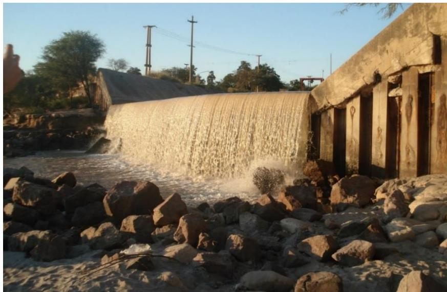
Figura 3: Canal de fuga do sistema de irrigação do rio Dulce 220 m a jusante do dique Los Quiroga (Santiago del Estero, Argentina). O fundo do canal coincidia com o leito do rio quando a operação do barramento iniciou em 1950 (foto do autor, 2017).
