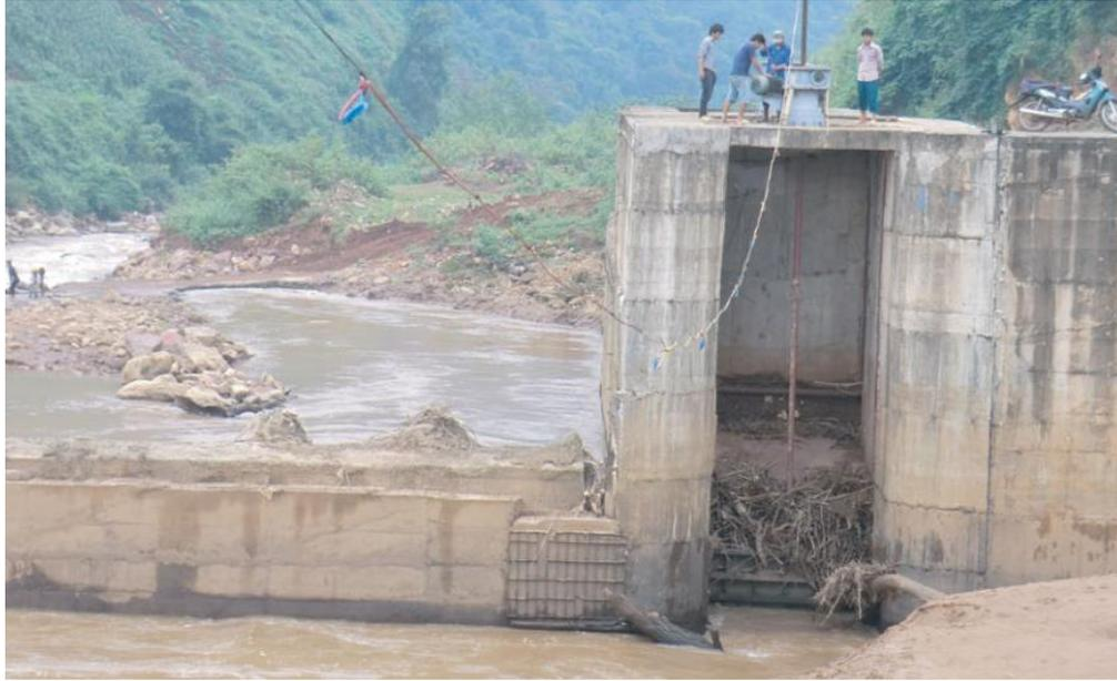
Figura 4: Tomada d'água bloqueada por sedimentos e outros detritos durante a construção da barragem Ta Niet no Vietnã (Fonte: adaptado de Schleiss et al. (2016)).
