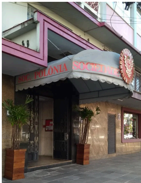
Figura 5 - Prédio sede da Sociedade Polônia de Porto Alegre
