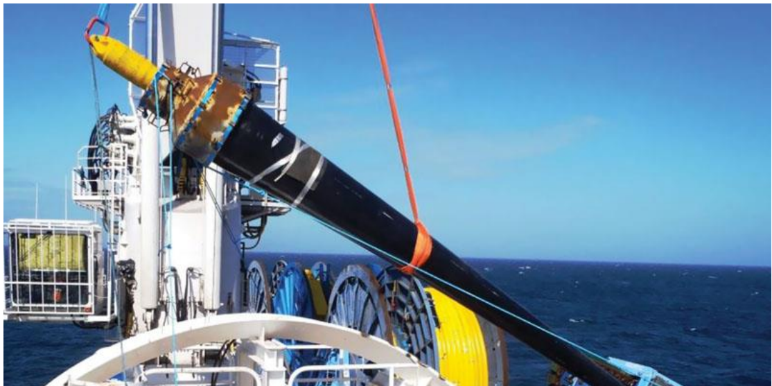
Figura 13 – Bend stiffener sendo retirado de operação.
