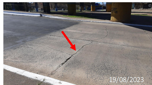
Figura 28 - Desníveis no passeio e fissuras
