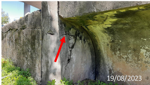
Figura 21 - Encontro 01 rompido do Viaduto pista esquerda
