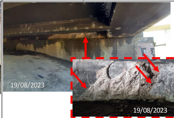
Figura 20 - Vigas transversina no encontro 01 do Viaduto pista esquerda
