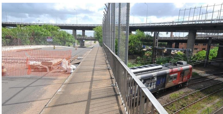
Figura 28. Fotografia realizada durante as obras de intervenções.
