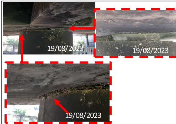
Figura 25 - Viaduto pista direita: P2 quebra de cantos por falta de folga entre extremidade de viga e pilar. O aparelho de apoio apresenta bloqueio e distorção
