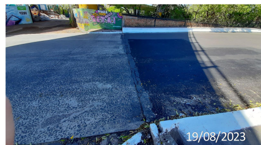
Figura 30 - Fissuras no pavimento de acesso
