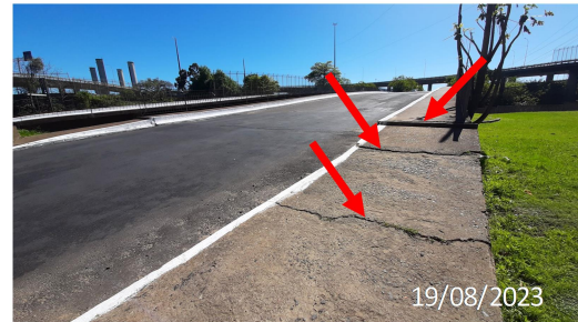
Figura 28 - Desníveis no passeio e fissuras
