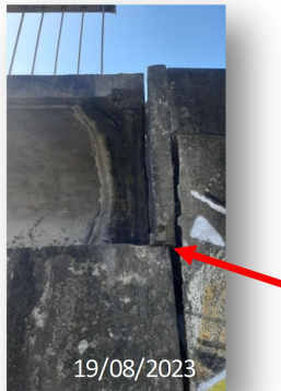
Figura 21 - Encontro 01 rompido do Viaduto pista esquerda
