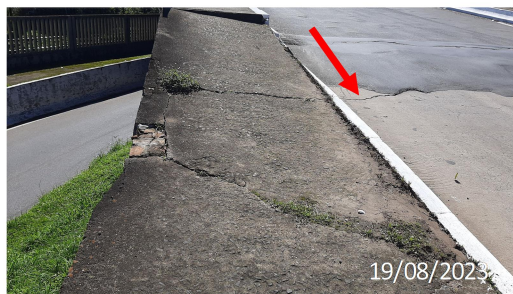
Figura 27 - Desníveis no passeio e fissuras
