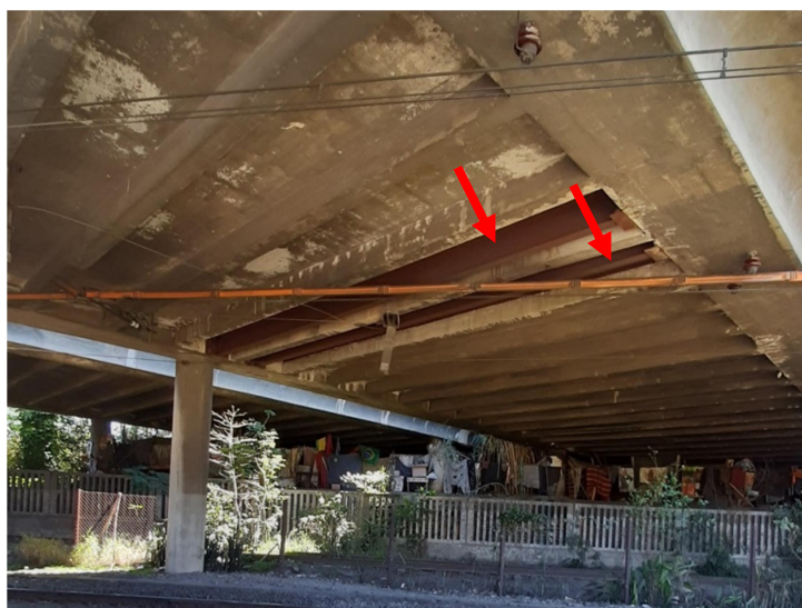
Figura 29. Vista das vigas transversinas de aço.
