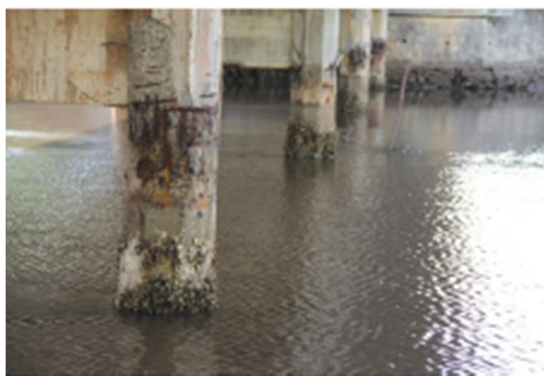
Figura 17. Ação por ataque de cloretos.
