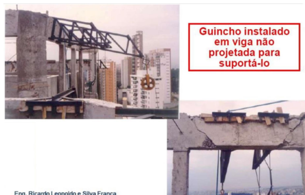
Figura 15. Detalhe de fissuras por torção.
