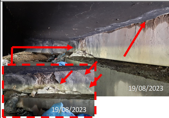
Figura 19 - Vigas transversina no encontro 01 do Viaduto pista esquerda
