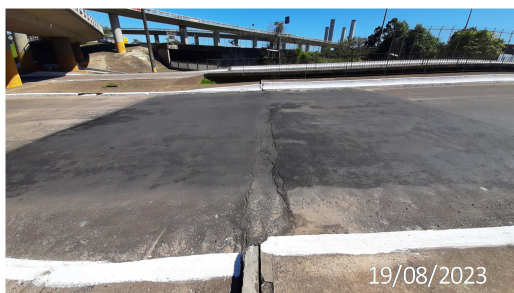
Figura 29 - Fissuras no pavimento de acesso
