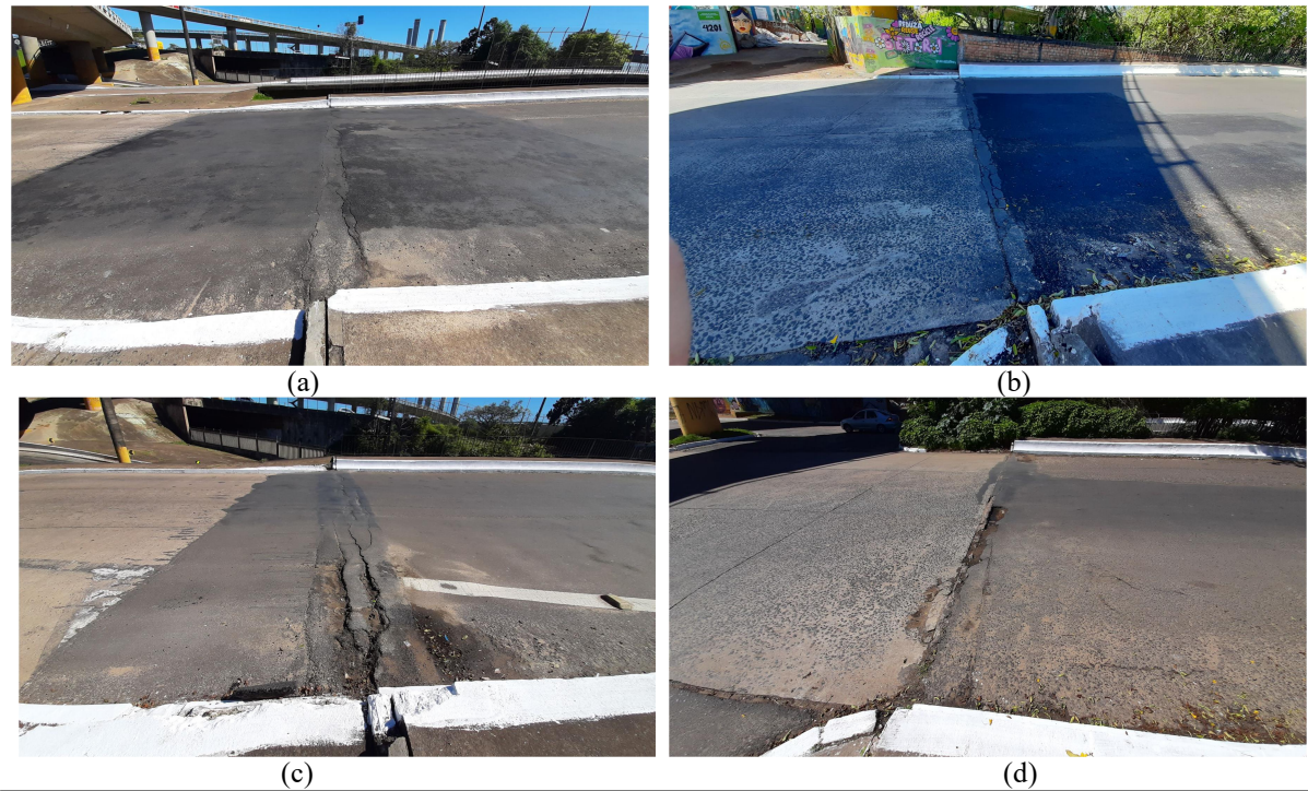
Figura 43. Fotos das juntas de dilatação. Juntas de dilatação 01 (a) e 02 (b) pista direita e juntas de dilatação 01 (c) e 02 (d) pista esquerda; Mapeamento das fotos (e)
