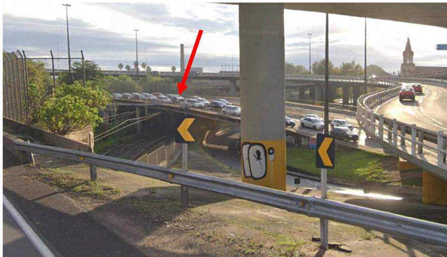
Figura 3. Vista lateral leste do viaduto.
