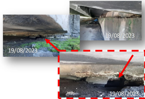
Figura 22 - vista do tubo de ancoragem encontro 01 pista esquerda
