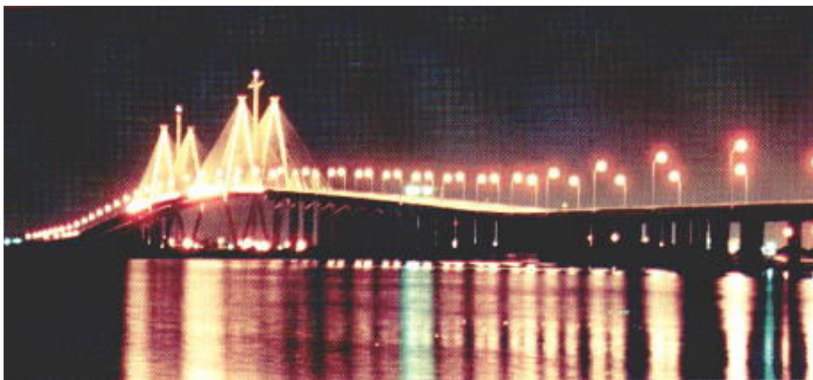
Fig. 1.14 – Ponte Baytown, Texas.
