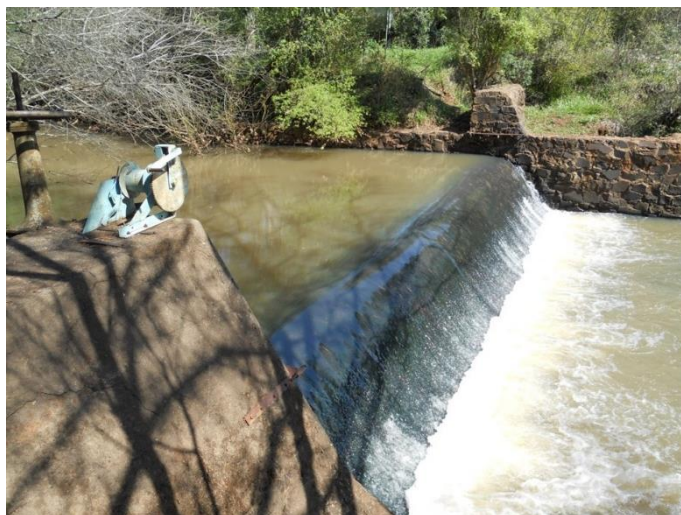
Figura 5. Barragem de abastecimento existente no rio Santo Cristo.
