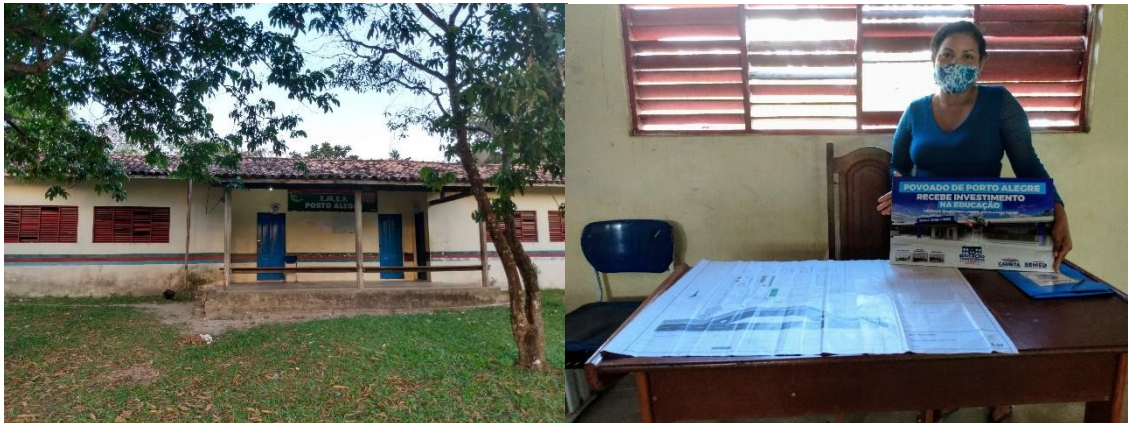
Figura 10 - Escola municipal de Porto Alegre, Cametá, Pará (2021)
