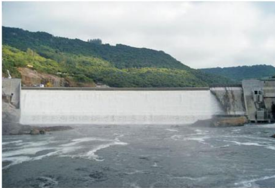
Figura 8 - Vista da UHE Castro Alves.
