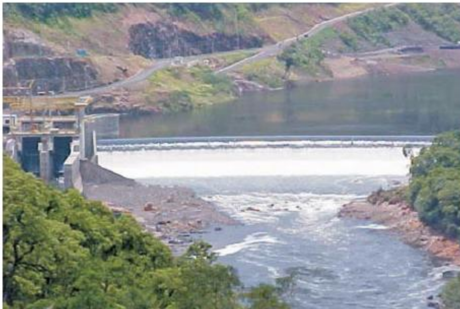
Figura 10 - Vista da UHE Monte Claro.
