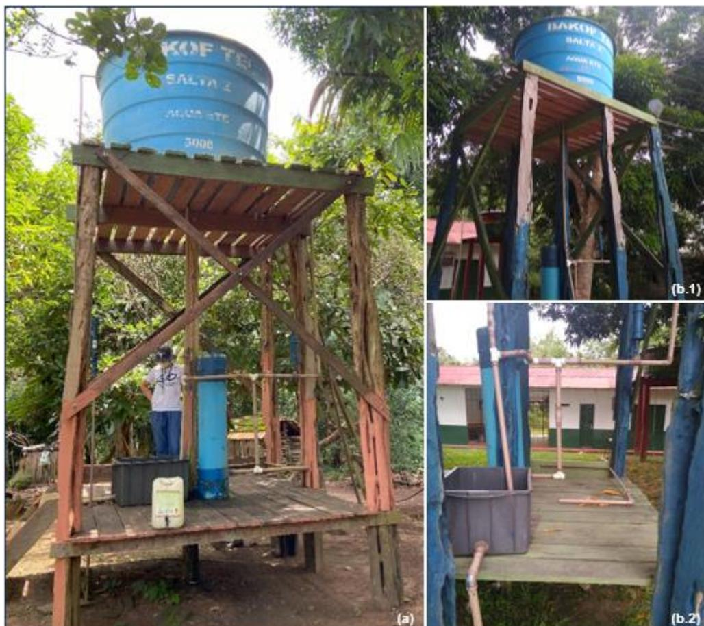
NOTA: Sistema de tratamento de água SALTA-Z: (a) Sistema em operação; (b.1 e b.2) Sistema desativado que fica próximo à escola da comunidade quilombola. A imagem b.2 apresenta a falta de parte da tubulação.
