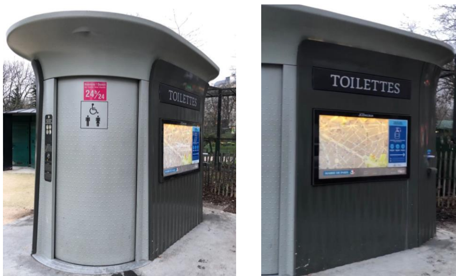
Figura 27 – Banheiro público autônomo
