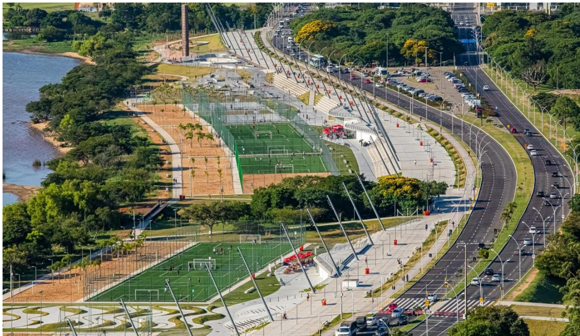
Figura 20 – Imagem aérea das quadras de esportes: trecho III
