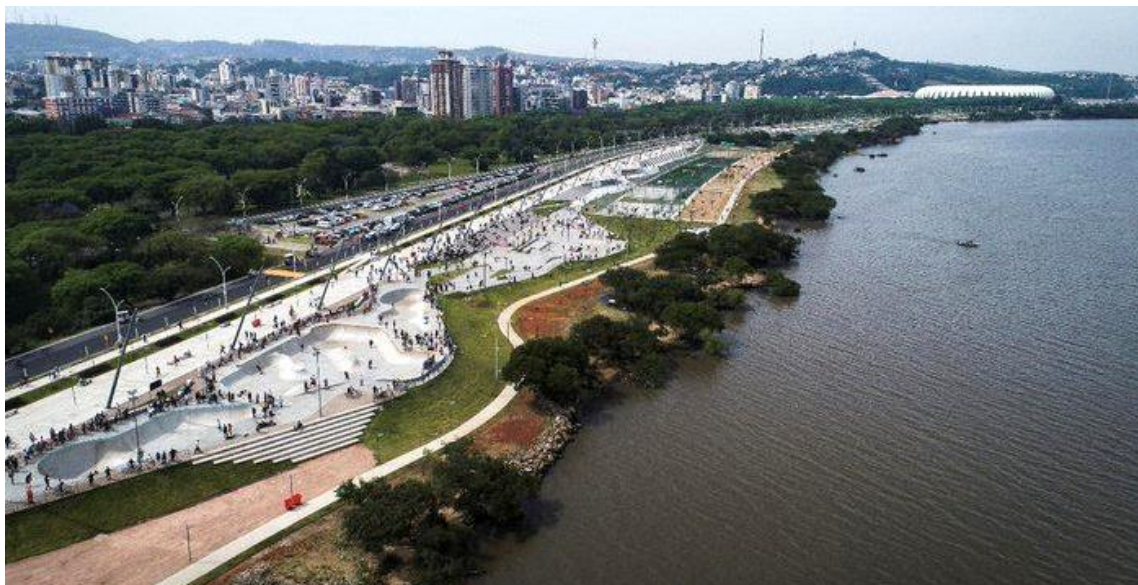
Figura 17 – Imagem aérea do trecho III
