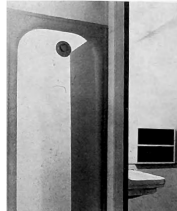
155 — Detalhe do acesso à cabine de banho.
