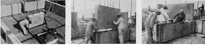
34 — Montagem com blocos de concreto pré-fabricados no Siedlung Praunheim .
