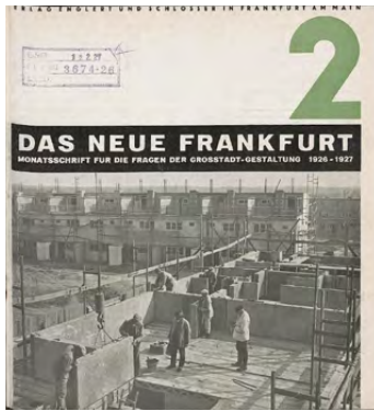
35 — Capa da segunda edição da Revista Das Neue Frankfurt, 1926-27, mostrando o canteiro de obras com elementos pré-fabricados do Siedlung Westhausen .
