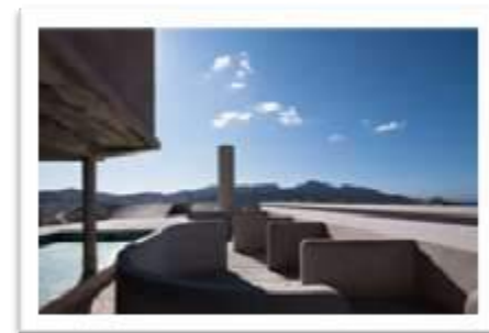
Figura 4-271: Solário. Fonte: A caixa negra.
