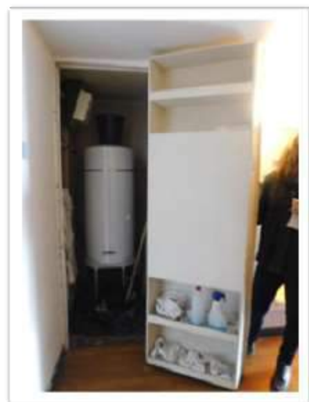
Figura 4-213, 4-214, 4-215 : Armário para o boiler na Porção central da célula. Fonte: Arquivo pessoal.
