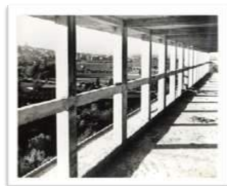
Figura 3-56: A estrutura do Bouteille Bouteiller – Lajes do 17º e 18º níveis s. Fonte: FONDATION LE CORBUSIER
