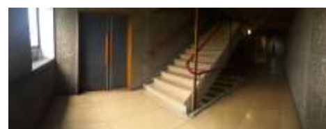
Figura 4-105, 4-106: Escada de incêndio. Fonte: Arquivo pessoal.
