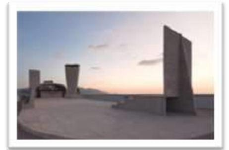
Figura 4-260: Lado norte do terraço-jardim-teatro, chaminé e academia. Fonte: FONDATION LE CORBUSIER.
