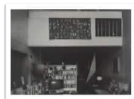
Figura 4-204: Sala de estar do apartamento N°. 50. Fonte: RÜEG, Arthur et al., 2015.
