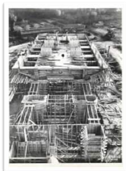
Figura 3-76: Execução do pavimento técnico, face Sul 15/11/1948 . Fonte: FONDATION LE CORBUSIER
