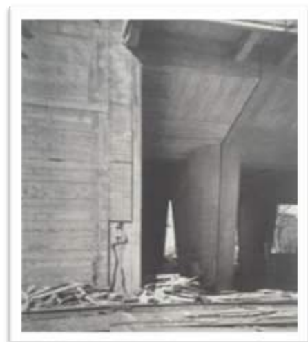
Figura 3-46: Baixo Relevo do Modulor esculpido na fachada, no canteiro de obras. Fonte: FONDATION LE CORBUSIER
