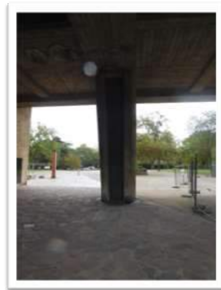
Figura 4-62: Vista frontal do pilotis , mostrando o fechamento do duto de passagem de canalizações. Fonte: Arquivo Pessoal.
