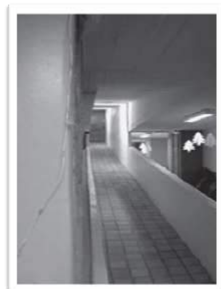
Figura 4-243, 4-244, 3-245: Escola Maternal Fonte: FONDATION LE CORBUSIER.
