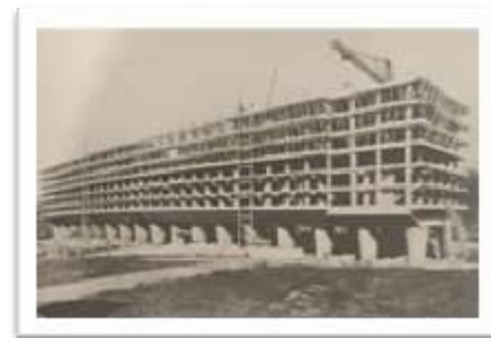
Figura 3-79: Andamento da obra, 13/03/1949 . Fonte: FONDATION LE CORBUSIER
