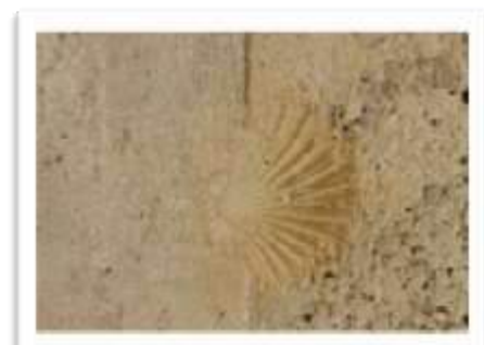
Figura 4-84: Detalhe de baixo relevo de concha do concreto das paredes do Hall de entrada. Fonte: Arquivo Pessoal
