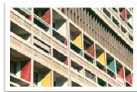
Figura 4-34: Detalhe da fachada oeste mostrando os dois tipos de brises-soleil utilizados na Unité . Fonte: SBRIGLIO, Jacques, 2013.
