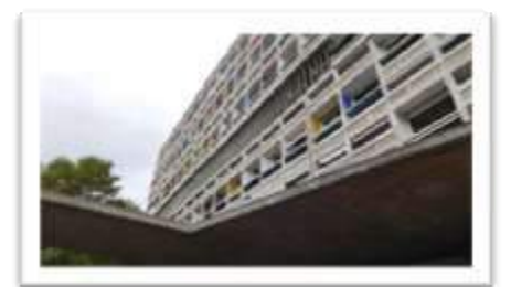
Figura 4-32: Vista da fachada Oeste a partir da entrada. Fonte: Arquivo pessoal
