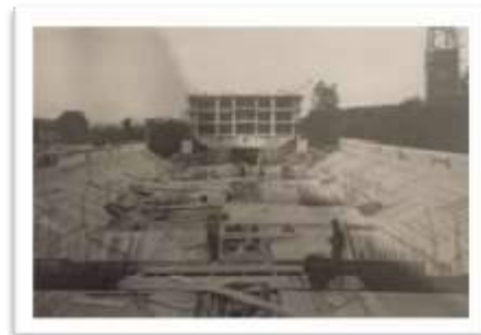
Figura 3-74, 3-75: Andamento das obras, 09/1948 . Fonte: FONDATION LE CORBUSIER
