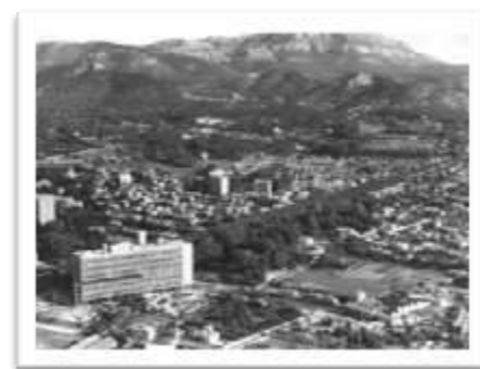
Figura 3-36: A unité , finalizada, às margens do Boulevard Michelet. Fonte: FONDATION LE CORBUSIER.
