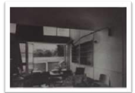
Figura 4,161, 4-162: Sala de Jantar, a partir da cozinha. Fonte: FONDATION LE CORBUSIER.
