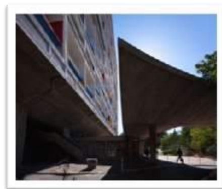
Figura 4-65: Vista " La casquete"pelo acesso de automóveis. Fonte: A caixa Negra.
