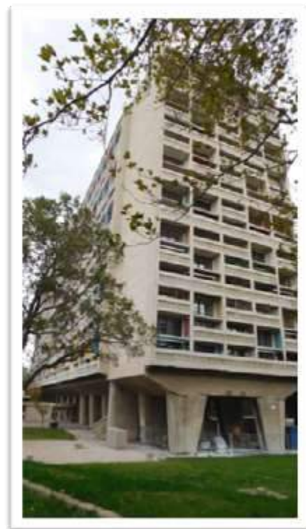
Figura 4-42: Articulação entre a Fachada Sul e a Fachada Oeste. Fonte: Arquivo Pessoal.
