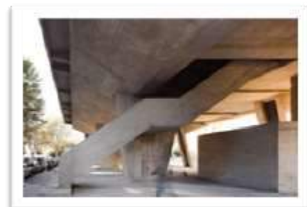
Figura 4-64: Vista da escada de incêndio junto aos pilotis , mostrando o duto de passagem de canalizações. Fonte: FONDATION LE CORBUSIER
