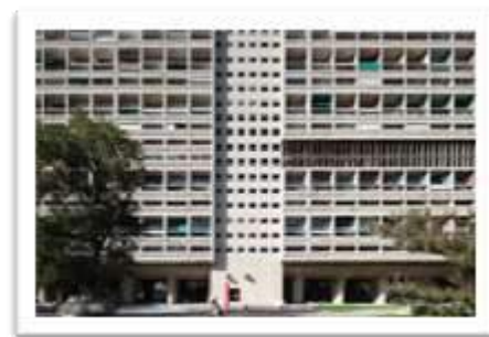
Figura 4-18: Vista da Praça seca a partir do acesso principal . Fonte: A caixa negra.
