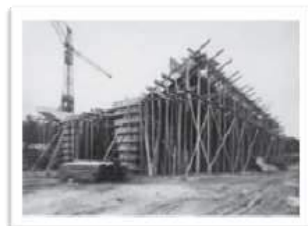
Figura 3-72: Execução dos Pilotis do Bloco Norte. 21/04/1948. Fonte: FONDATION LE CORBUSIER
