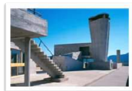
Figura 4-266: Área central do terraço-jardim – pista, Acesso, chaminé e extensão da escola maternal. Fonte: FONDATION LE CORBUSIER.
