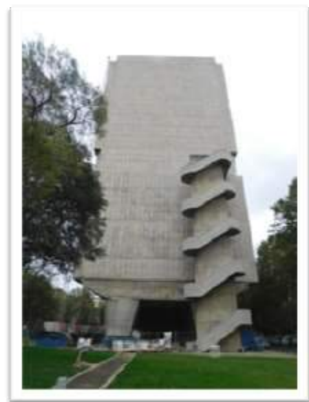
Figura 4-48: Fachada Norte. Fonte: Arquivo Pessoal.
