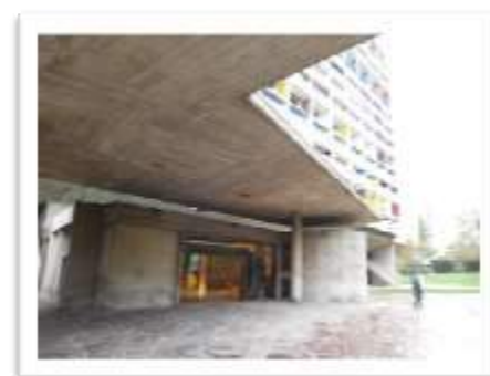
Figura 4-74: Vista externa do Hall de entrada. Fonte: Arquivo Pessoal.
