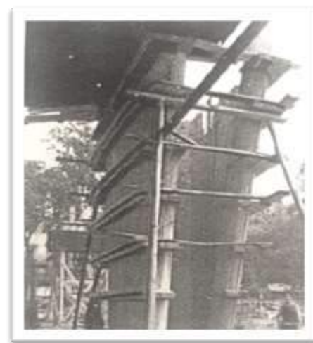
Figura 2-59: Execução dos pilares. Fonte: FONDATION LE CORBUSIER
