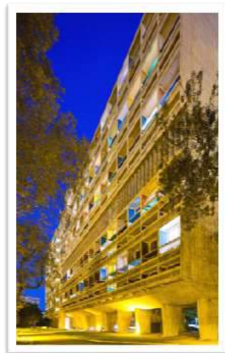
Figura 4-54, 4-55,4-56: Vista dos pilotis junto às fachadas. Fonte: A caixa negra.
