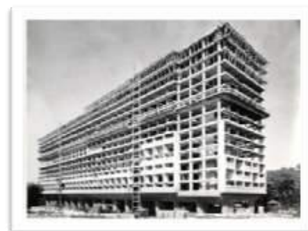
Figura 3-81: Imagem do canteiro de obras em 29/08/1949 . Fonte: FONDATION LE CORBUSIER
