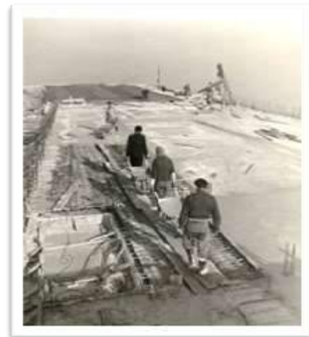
Figura 3-82: Concretagem da laje de cobertura. Fonte: FONDATION LE CORBUSIER
