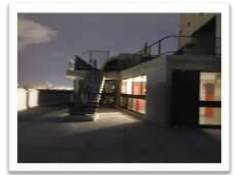
Figura 4-260: Acesso ao terraço-jardim. Fonte: Arquivo pessoal.
