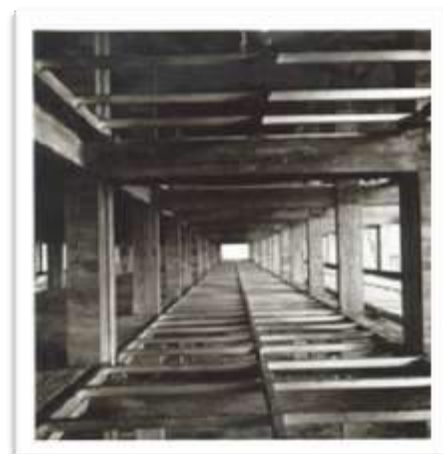
Figura 3-55: A estrutura do Bouteille Bouteiller - Estrutura independente de concreto armado e subestrutura metálica das células. 05/1949 Fonte: FONDATION LE CORBUSIER
