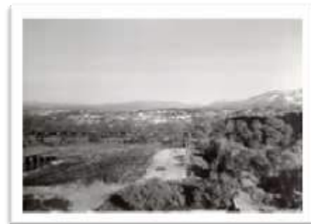
Figura 3-71: Imagem referente ao estágio inicial de execução da Unité. Fonte: FONDATION LE CORBUSIER
