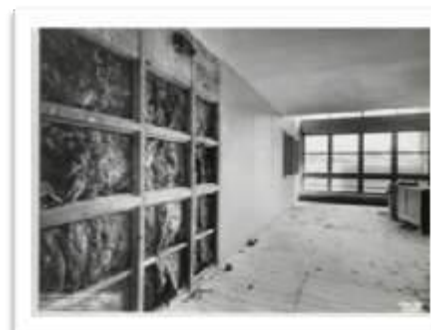
Figura 3-61: Montagem do revestimento interno das células 11/11/1949 . Fonte: FONDATION LE CORBUSIER
