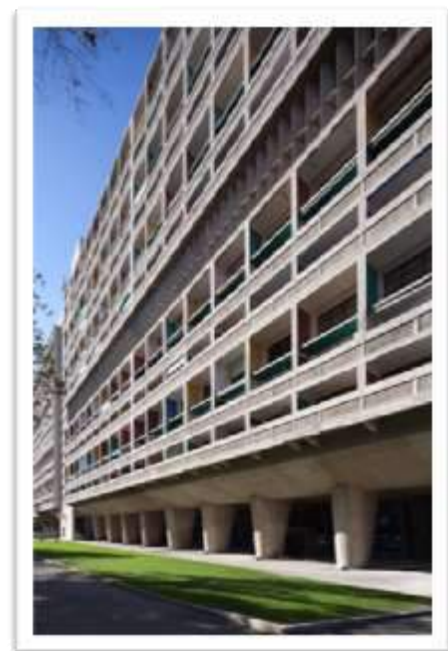
Figura 4-38, 4-39: Fachada Leste. Fonte: A caixa negra
