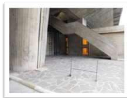
Figuras 3-60: Escada de Incêndio: arquivo pessoal.
