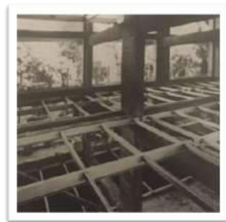
Figura 3-80: Colocação da subestrutura metálica, 08/06/1949 . Fonte: FONDATION LE CORBUSIER
