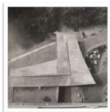
Figura 4-66: Vista superior " La casquete"Fonte: FONDATION LE CORBUSIER.
