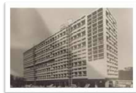
Figura 3-85: Foto da obra, final de 1950 Fonte: FONDATION LE CORBUSIER
