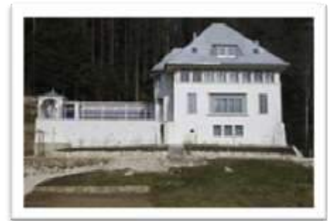
Figura 1-51: Villa Jeanneret, de 1912, em La Chaux-de-Fonds. Fonte: FONDATION LE CORBUSIER.
