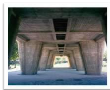
Figura 4-57: Vista dos pilotis sob o edifício. Fonte: FONDATION LE CORBUSIER.
