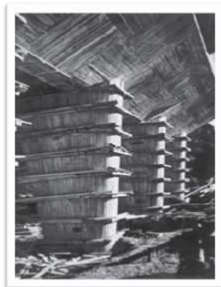
Figura 3-77: Pilotis do Bloco Sul . Fonte: FONDATION LE CORBUSIER
