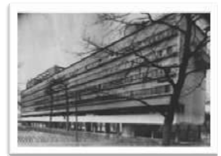
Figura 1-89: edifício Narkofim , de 1928-1929
