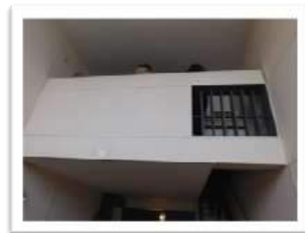
Figura 4-172: Vista do guarda-corpo do mezanino. Fonte: Arquivo pessoal
