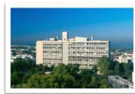
Figura 4-4: Vista aérea da Unité. Fonte: FONDATION LE CORBUSIER
