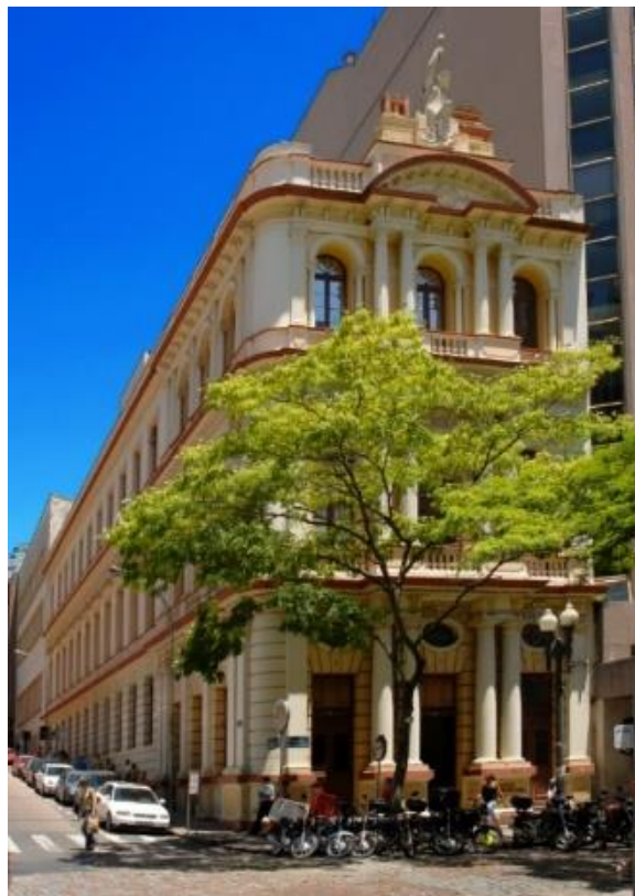
Figura 1 – Imagem do prédio do MuseCom
