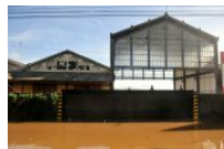
O sistema de proteção contra inundações de Porto Alegre
