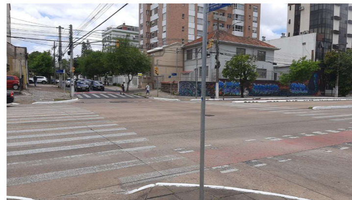
Cruzamento aberto, mal sinalizado e sem refúgio ou sinaleira para pedestres
