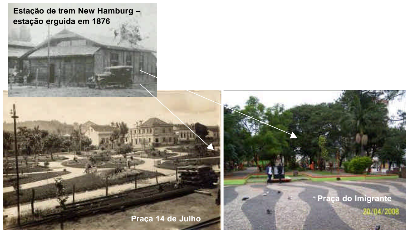
FIGURA 52 – A ESTAÇÃO DE TREM DO CENTRO DE NOVO HAMBURGO - RS Detalhe: No local onde estava a estação de trem de New Hamburg foi erguida a Praça 14 de Julho que hoje se chama Praça do Imigrante. Atualmente não existe qualquer vestígio da estação, nem da praça anterior. FONTES: Fotos antigas acervo Fundação Scheffel. Data: s.d. Foto Praça do Imigrante, de Markus Wilimzig. Data: 20.04.2008.
