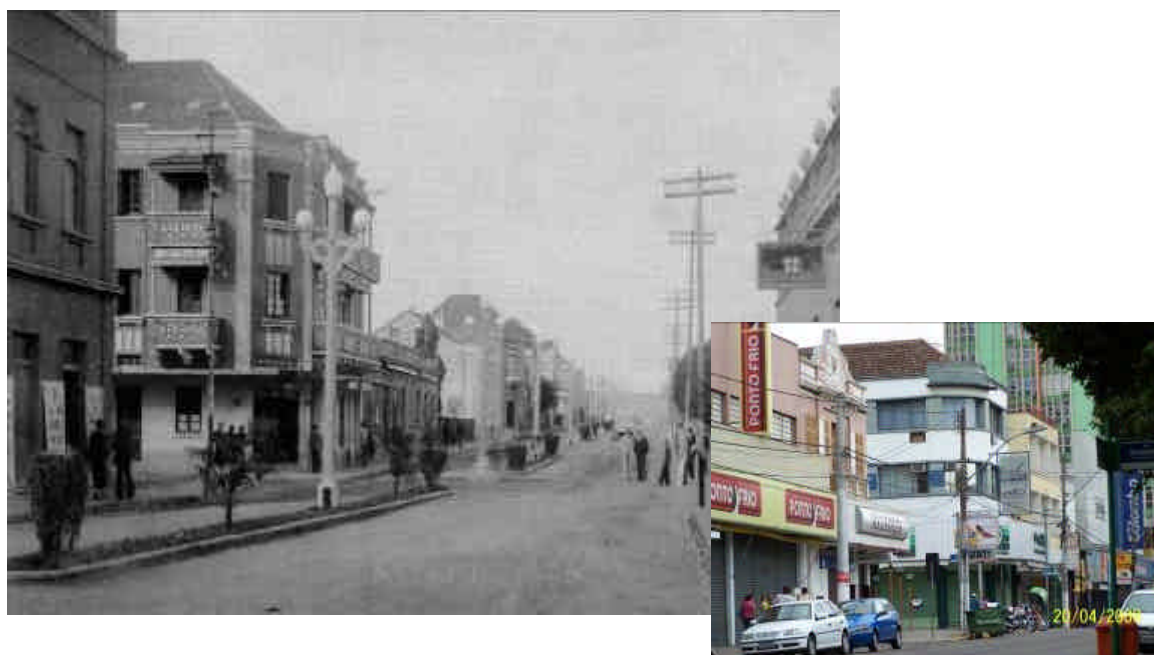
FIGURA 55 – HARMONIA URBANA II - AVENIDA PEDRO ADAMS Fº - CENTRO – NH – RS. Centro da cidade em 1940 e o mesmo lugar em 2008. FONTE: Foto à esquerda, acervo fundação Scheffel. Data: s.d. Foto à direita, de Markus Wilimzig. Data: 20.04.2008.
