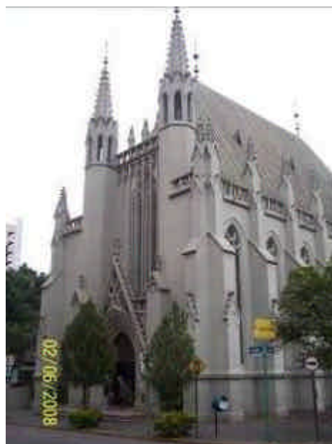
FIGURA 33 – IGREJA EVANGÉLICA DA ASCENSÃO – NOVO HAMBURGO - RS CONSTRUÇÃO EM 1951 FONTE: foto de Markus Wilimzig. Data; 02.06.2008.
