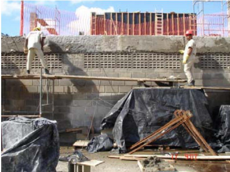
Figura 30 – Andaime improvisado em precárias condições somada a falta de EPI's nos trabalhadores.
