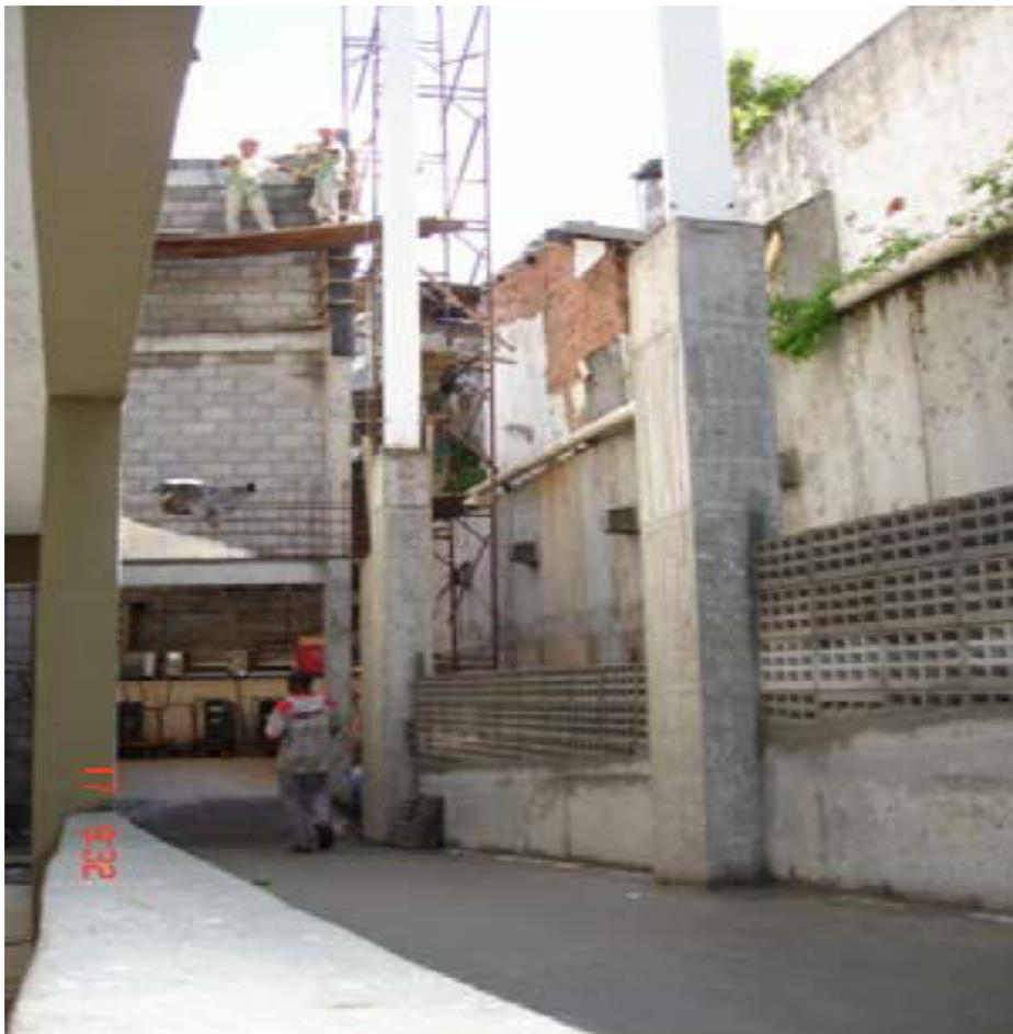
Figura 24: Trabalhador circulando em área não sinalizada e sob plataforma sem guarda-corpo e rodapé.
