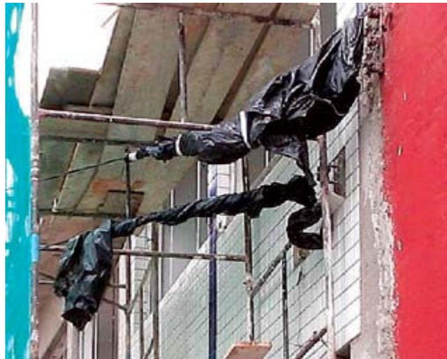
Figura 32: Isolamento improvisado: fios elétricos protegidos com plásticos e fita-crepe
