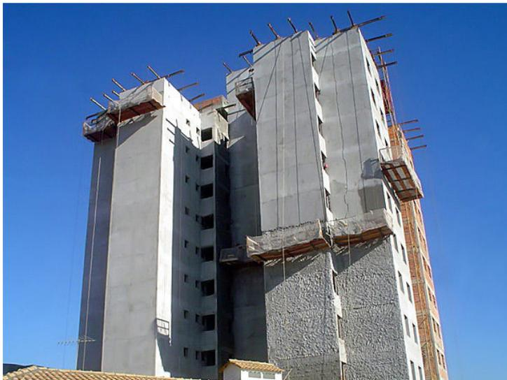
Figura 8: Equipamentos Utilizados: andaime suspenso
