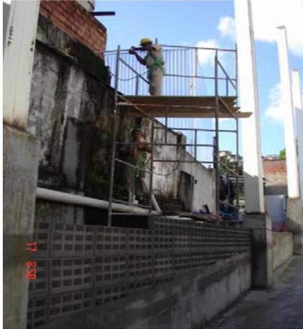
Figura 26 – Montagem do andaime de forma irregular e em local inadequado.
