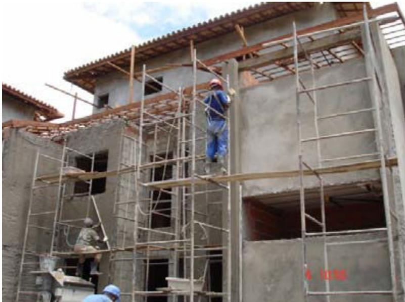
Figura 31: Plataforma de trabalho insuficiente
