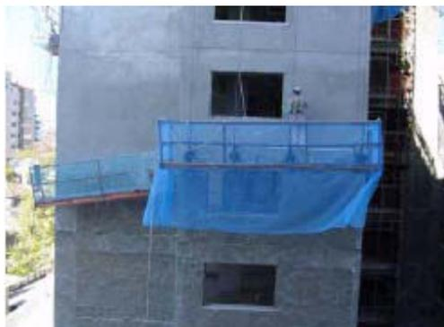
Figura 9: Vista frontal de um andaime leve (à esquerda) e de um pesado (à direita).
