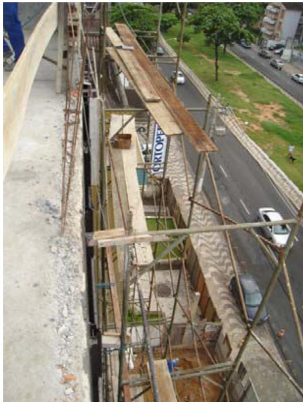
Figura 25 – Montagem de andaime mal projetada e defeituosa,
