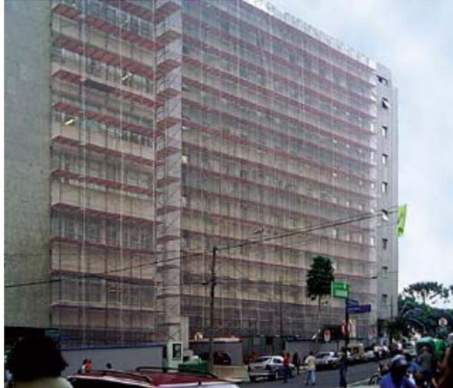
Figura 41: Sistema de proteção coletiva com tela
