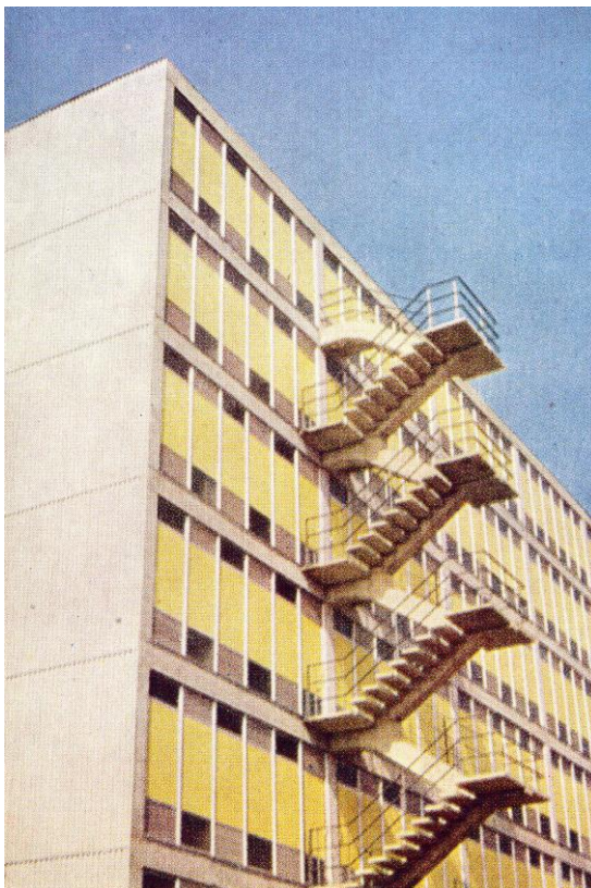
45. Bloco de apartamentos CRUSP, saída de emergência (Acrópole, 303, p. 96)
