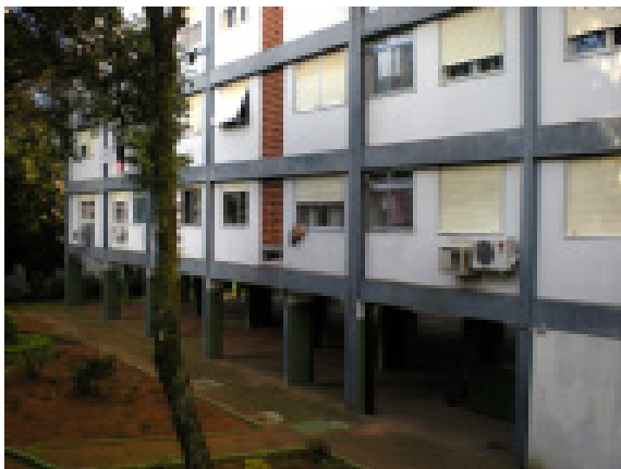
Edifício Y e desnível do terreno: subsolo sem uso
