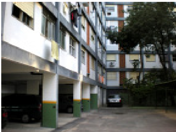
Edifício Y e desnível do terreno: subsolo com estacion.
