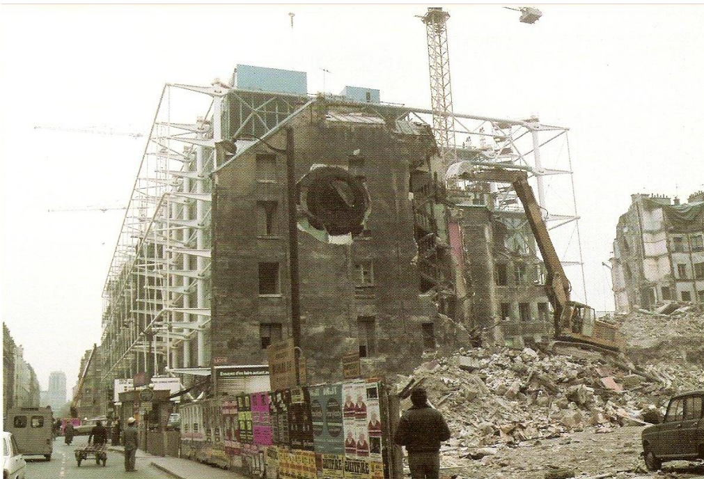
Figura 103: Vista de Conical Intersect durante sua demolição, 1975, fotografia.
