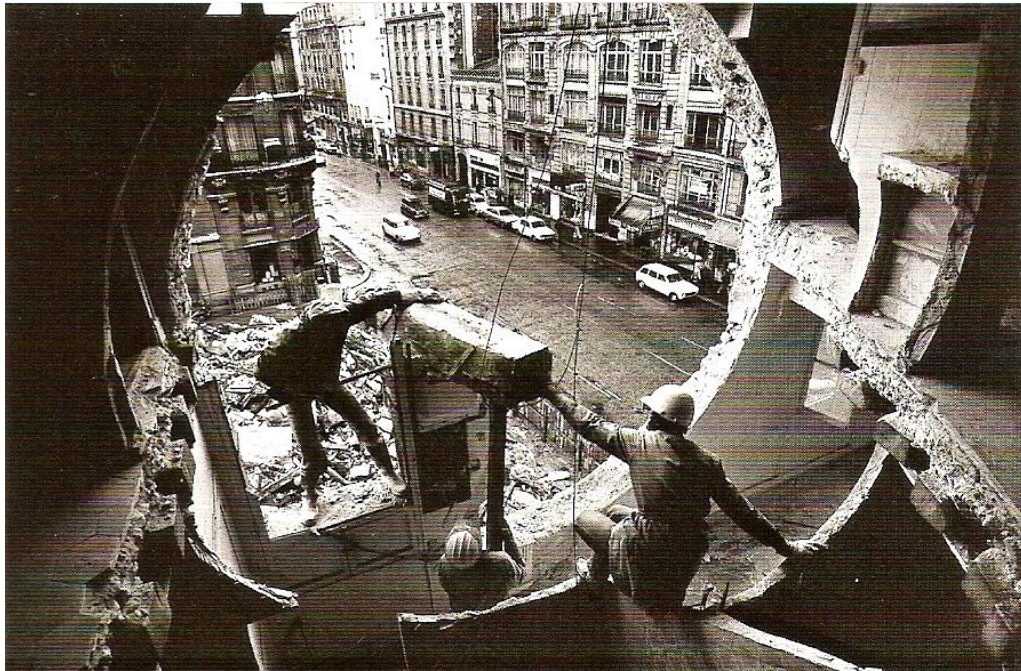
Figura 61: Conical Intersect sendo realizada, 1975, fotografia.
