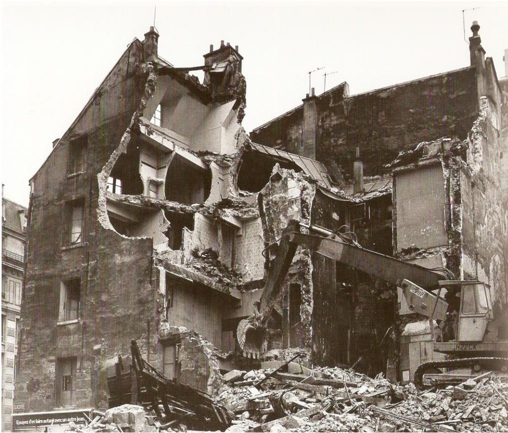
Figura 117: Vista de Conical Intersect durante sua demolição, 1975, fotografia.
