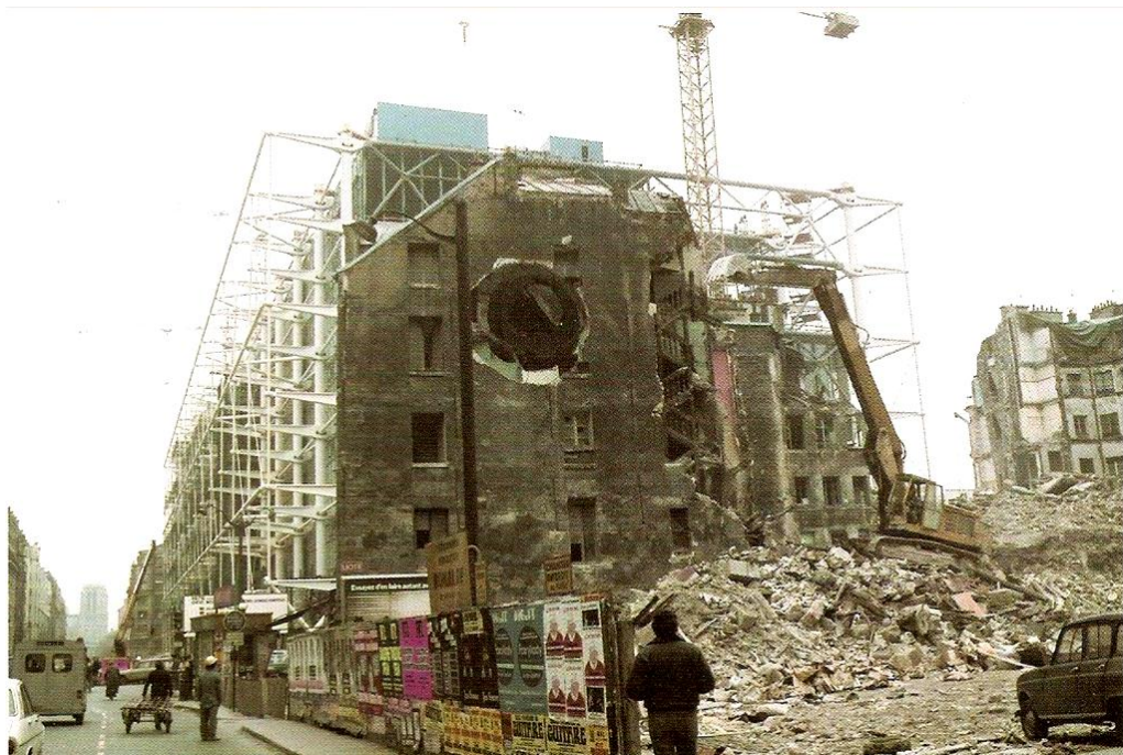
Figura 62: Vista de Conial Intersect durante sua demolição, 1975, fotografia.
